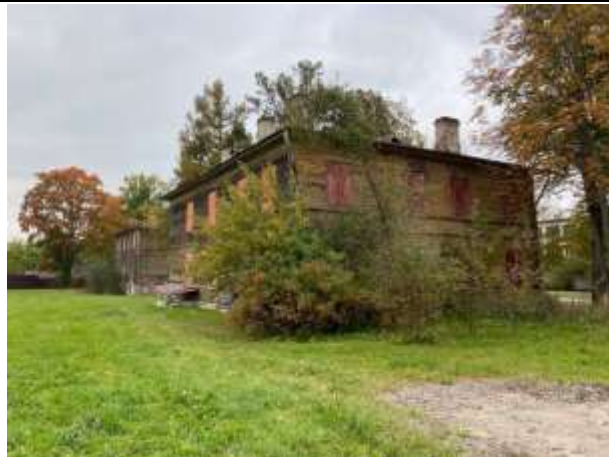
Фото № 4. Внешний вид здания
