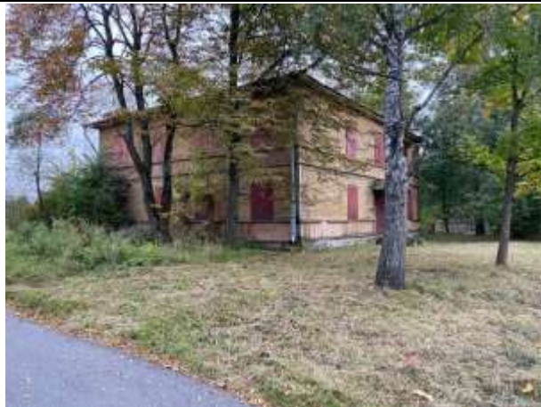
Фото № 3. Внешний вид здания
