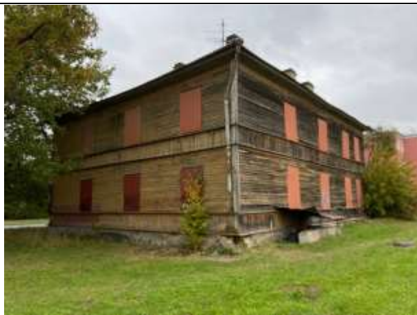
Фото № 5. Внешний вид здания
