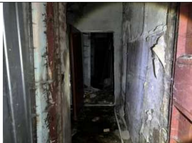
Фото № 8 – Внутреннее состояние помещения
