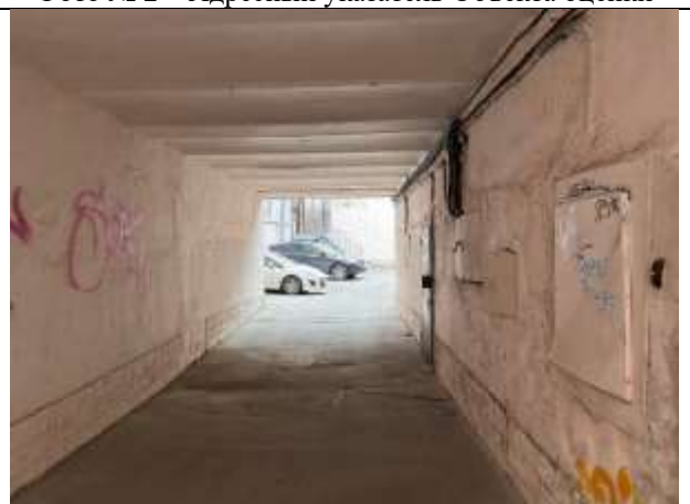
Фото № 4 – Вход в арку
