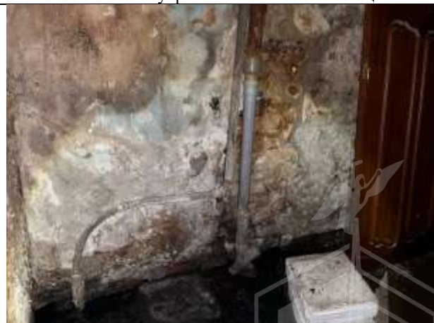
Фото № 14 – Внутреннее состояние помещения
