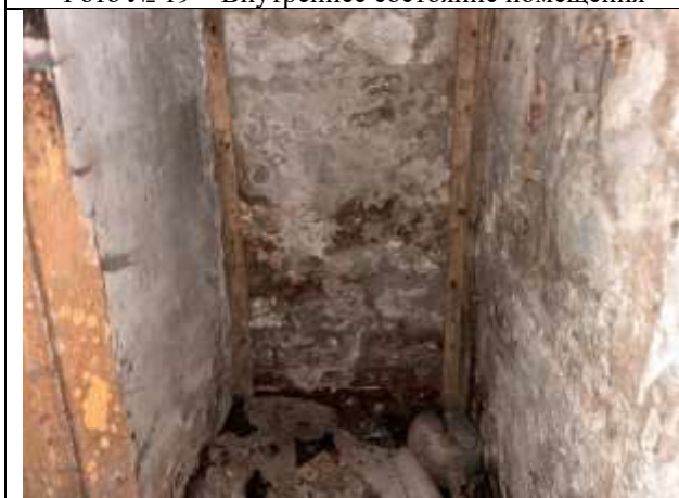
Фото № 21 – Внутреннее состояние помещения
