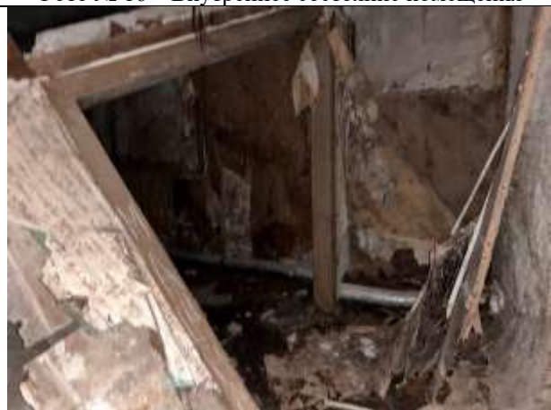
Фото № 18 – Внутреннее состояние помещения
