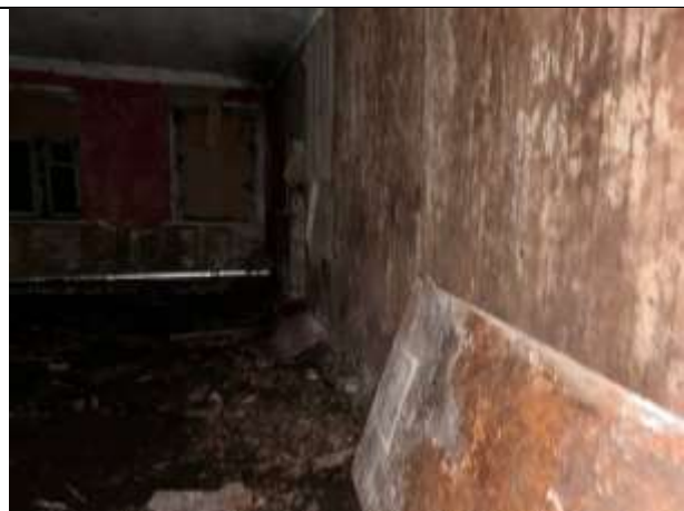
Фото № 16 – Внутреннее состояние помещения
