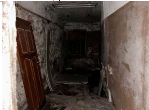
Фото № 10 – Внутреннее состояние помещения
