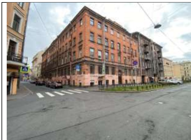
Фото № 1 – Подъездные пути к Объекту оценки
