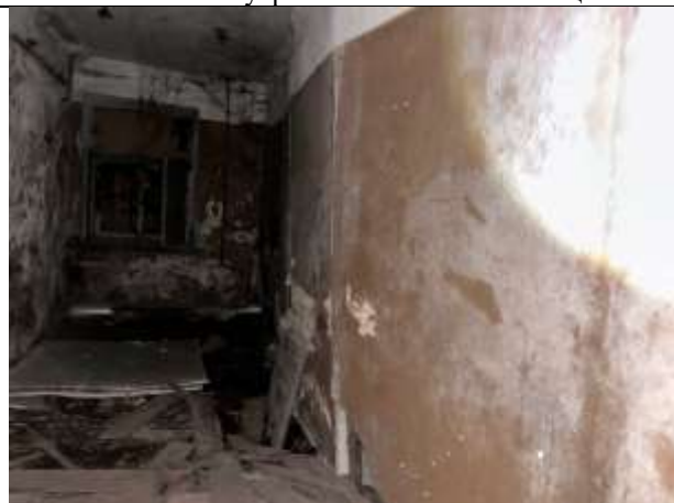
Фото № 13 – Внутреннее состояние помещения
