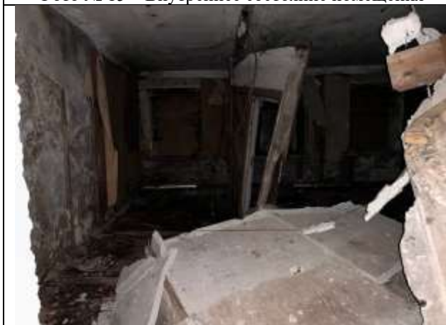
Фото № 17 – Внутреннее состояние помещения
