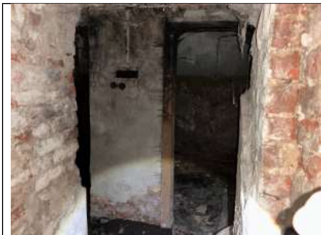
Фото № 15 – Внутреннее состояние помещения
