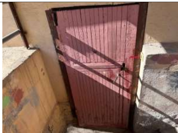
Фото № 6 – Вход в помещение
