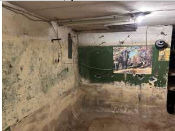
Фото № 16 – Внутреннее состояние помещения
