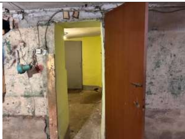
Фото № 18 – Внутреннее состояние помещения
