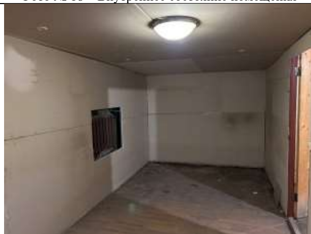
Фото № 20 – Внутреннее состояние помещения
