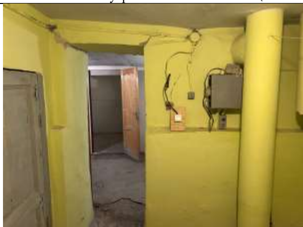
Фото № 13 – Внутреннее состояние помещения
