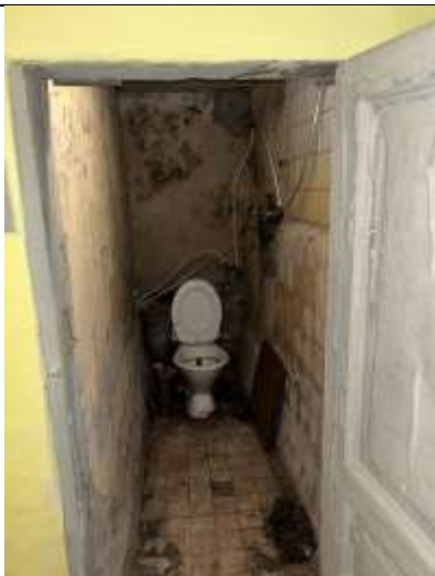
Фото № 11 – Внутреннее состояние помещения
