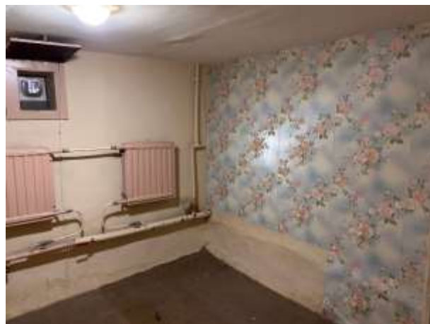
Фото № 12 – Внутреннее состояние помещения
