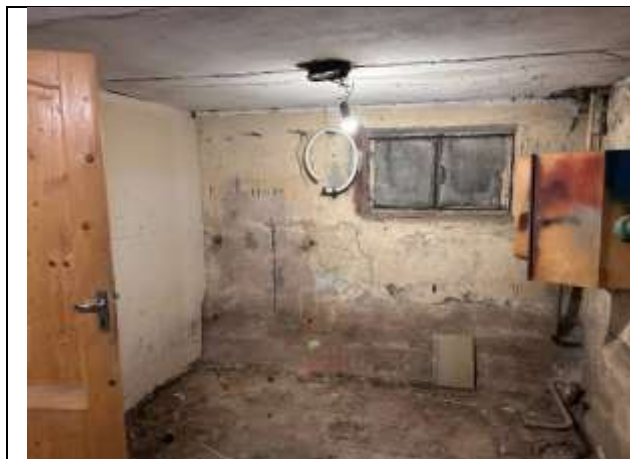
Фото № 17 – Внутреннее состояние помещения
