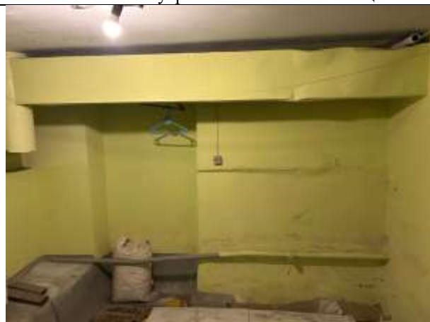
Фото № 14 – Внутреннее состояние помещения
