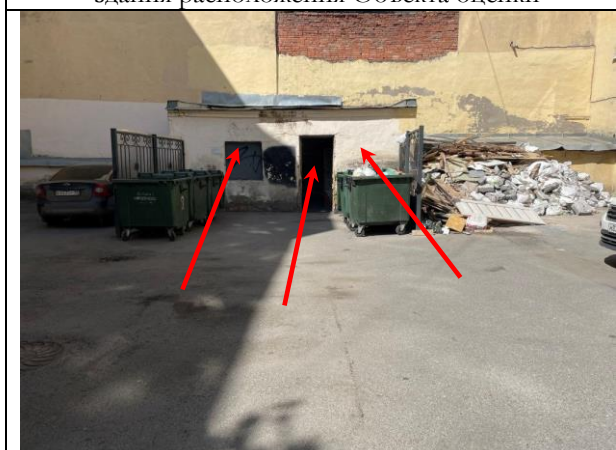
Фото 25. Вид здания расположения Объекта оценки, входная и оконная группа Объекта оценки
