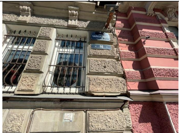
Фото 12. Адрес Объекта оценки
