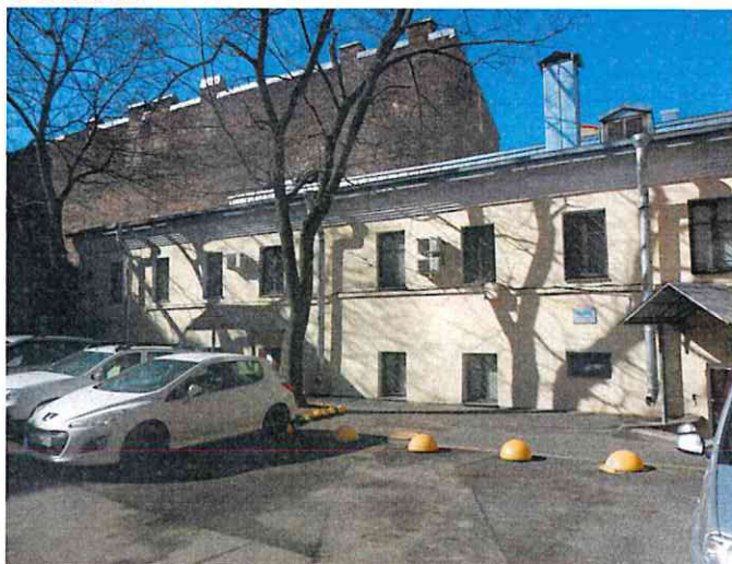
Фото №4 (вход в помещение)
