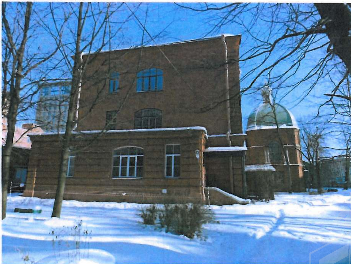
3. Западный торцевой фасад
