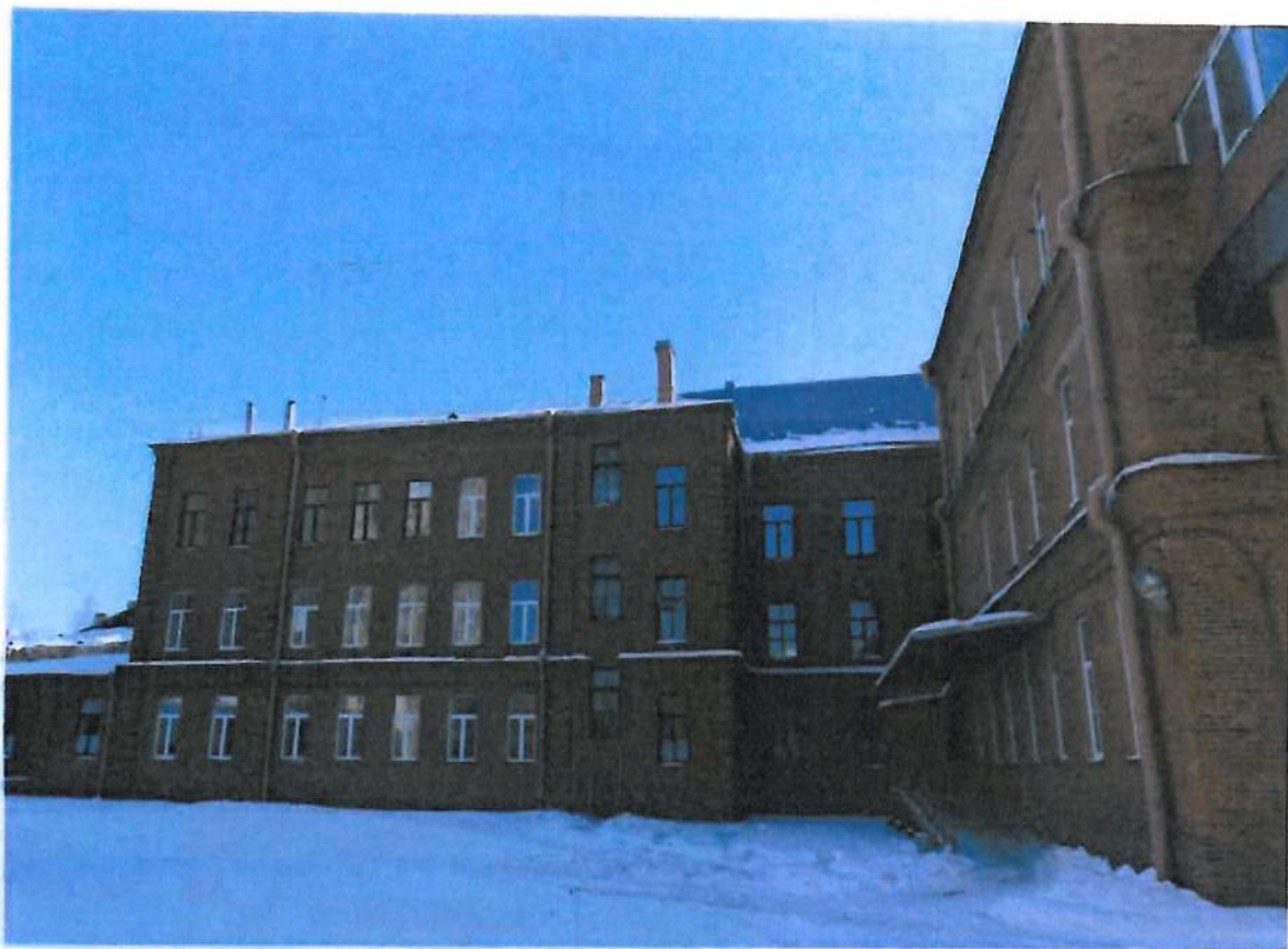
2. Северный фасад (восточная часть)
