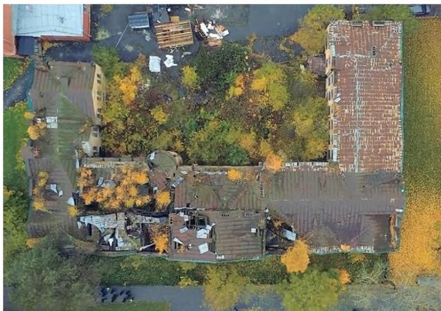
Фото 2. Вид сверху на Объект (ориентировочно, 2020 г.)
