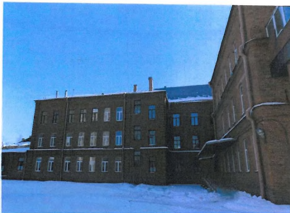
2. Северный фасад (восточная часть)
