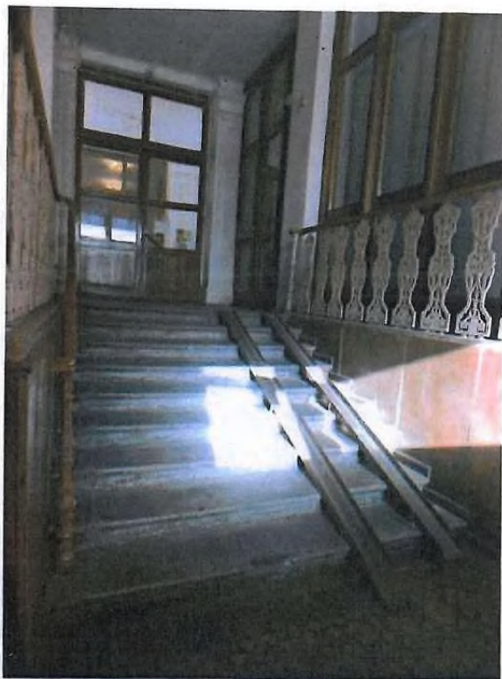
4. Лестница в вестибюле
