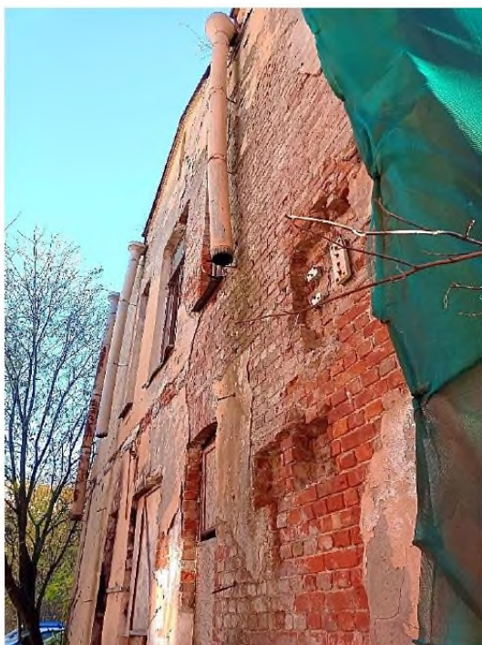
Фото 19. Вид на фрагмент северо-западного фасада
