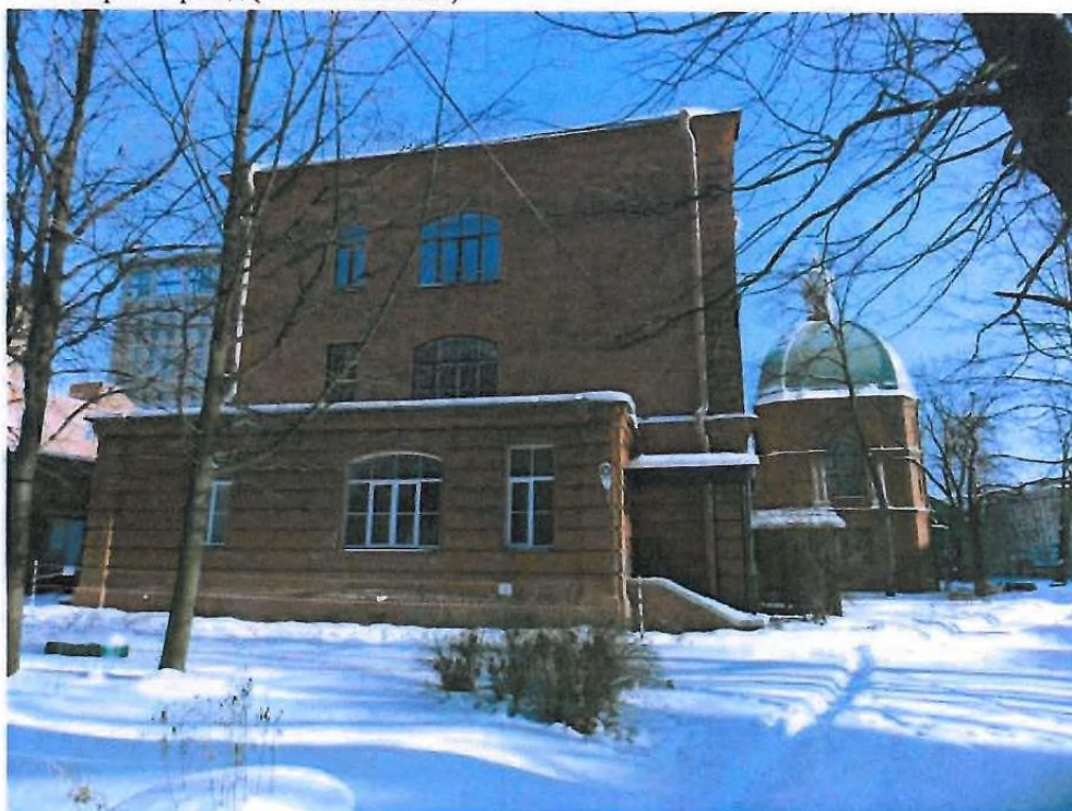
3. Западный торцевой фасад
