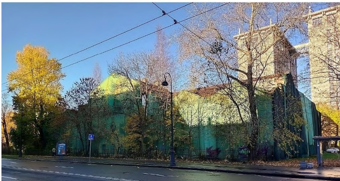
Фото 12. Вид на юго-восточный и северо-восточный фасады со стороны Большого проспекта В.О.
