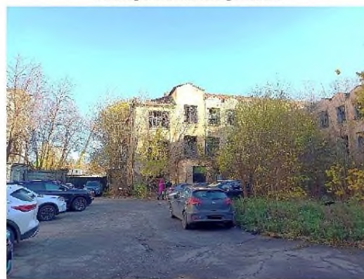
Фото 39. Вид на фрагмент внутреннего двора
