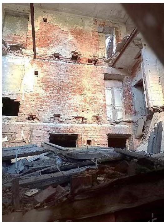
Фото 35. Вид через оконный проем северо-западного фасада на обрушенные межэтажные перекрытия
