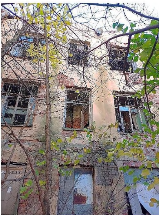
Фото 34. Вид на фрагмент северо-западного фасада
