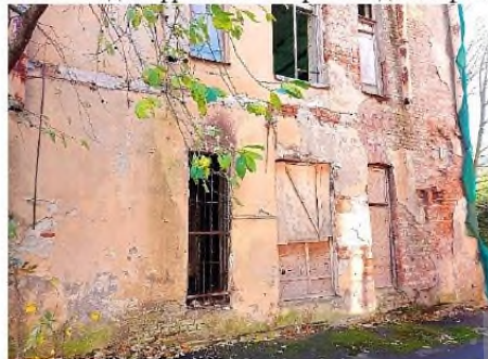
Фото 21. Вид на фрагмент северо-западного фасада
