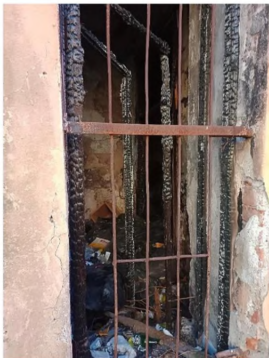
Фото 22. Вид на оконный проем ч.п.25 пом.1-Н (северо-западный фасад)
