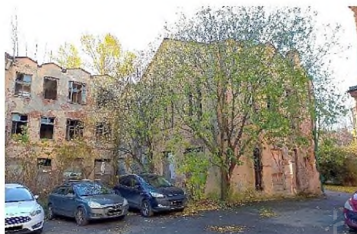
Фото 41. Вид на фрагмент внутреннего двора
