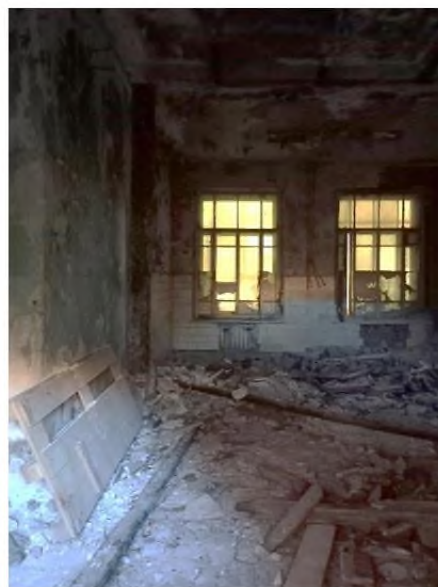
Фото 27. Вид через оконный проем ч.п.28 пом.1-Н (один из дворовых фасадов)
