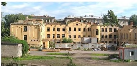
Фото 7. Вид на северо-западный фасад (2009 г., «Citywalls»)
