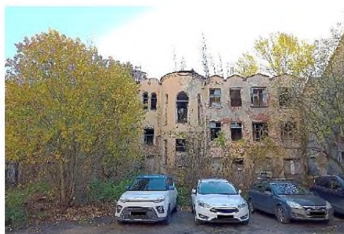
Фото 40. Вид на фрагмент внутреннего двора
