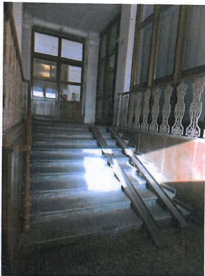
4. Лестница в вестибюле
