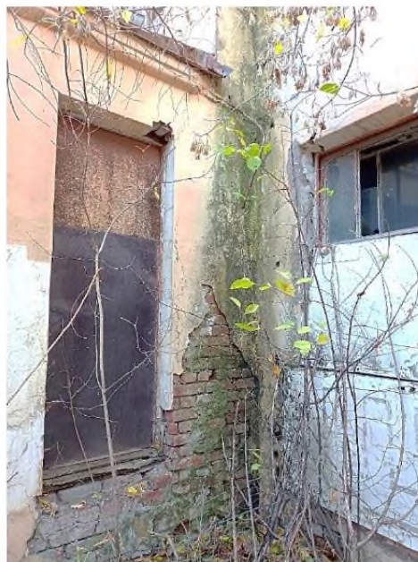
Фото 37. Вид на угол одного из дворовых фасадов с северо-западным фасадом
