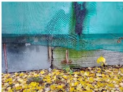
Фото 15. Вид на фрагмент юго-западного фасада
