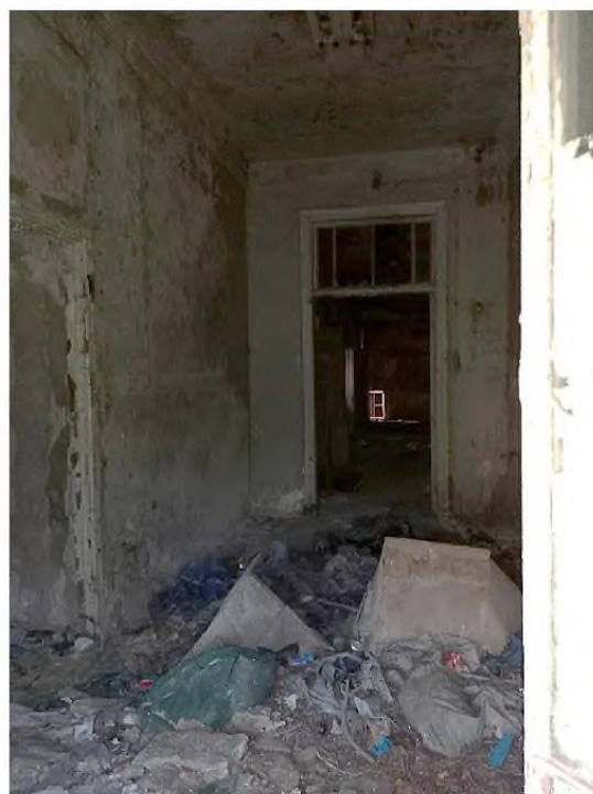
Фото 14. Вид на одно из помещений через незаполненный оконный проем с юго-восточного фасада
