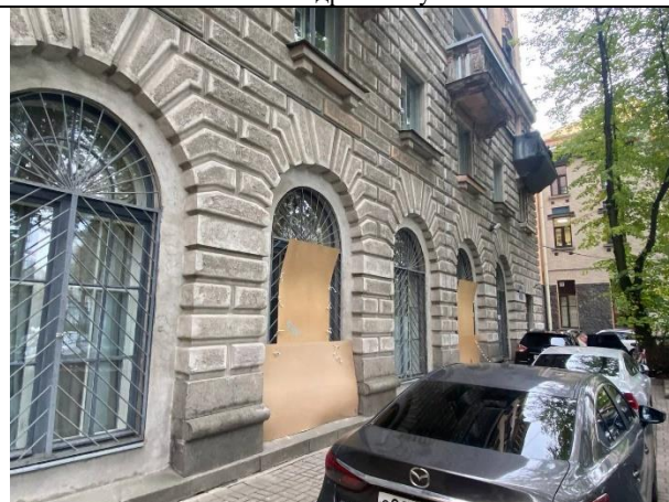
Фото № 4 – Окна в помещении
