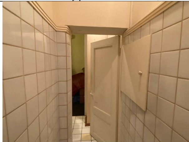
Фото № 12 – Внутреннее состояние помещения
