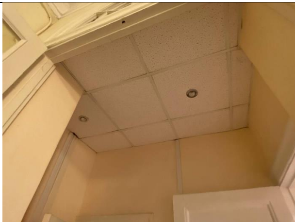
Фото № 9 – Внутреннее состояние помещения
