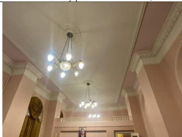
Фото № 20 – Внутреннее состояние помещения
