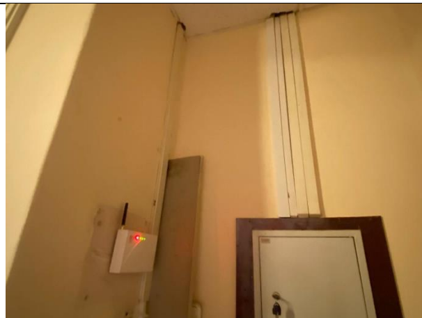
Фото № 10 – Внутреннее состояние помещения
