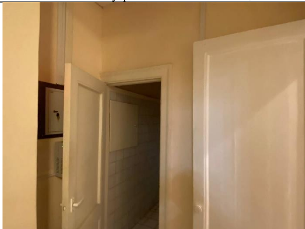
Фото № 11 – Внутреннее состояние помещения
