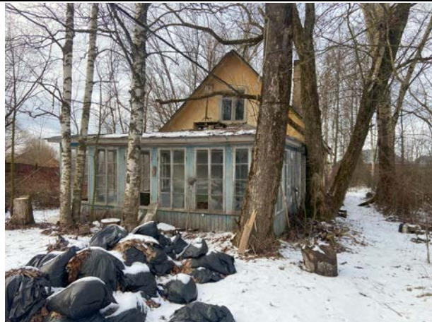
Фото № 6. Внешний вид здания литера А
