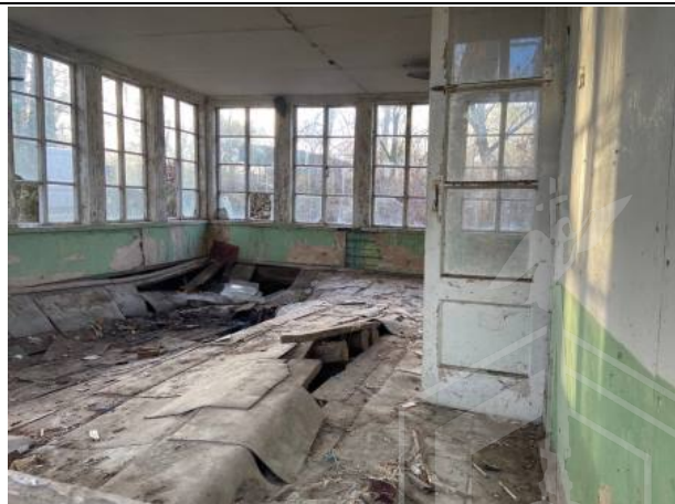
Фото № 8. Внешний вид здания литера Б
