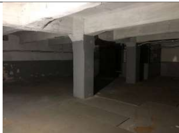
Фото № 24 – Внутреннее состояние помещения
