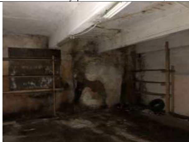
Фото № 19 – Внутреннее состояние помещения
