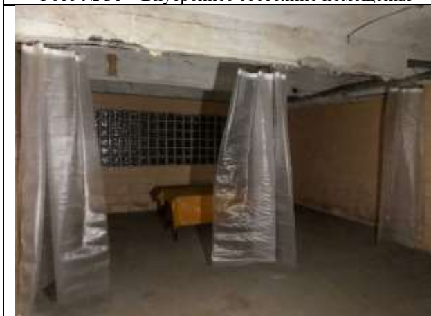
Фото № 33 – Внутреннее состояние помещения
