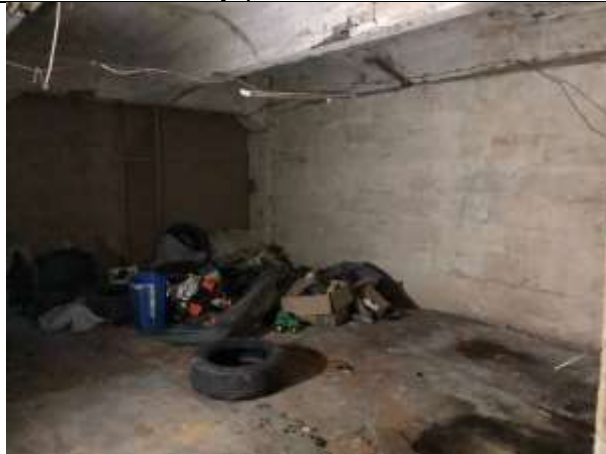
Фото № 41 – Внутреннее состояние помещения
