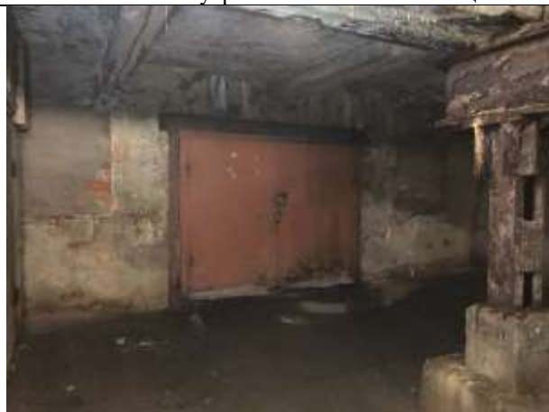
Фото № 13 – Внутреннее состояние помещения
