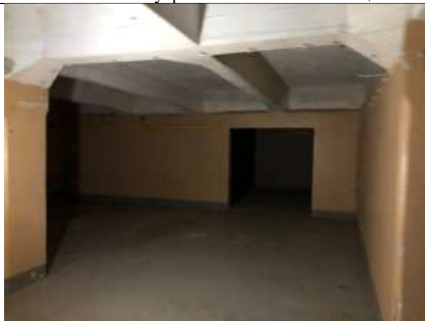
Фото № 43 – Внутреннее состояние помещения
