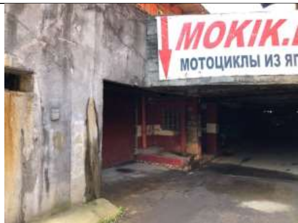
Фото № 8 – Вход в помещение
