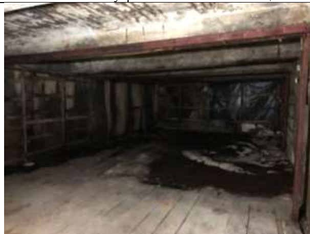
Фото № 44 – Внутреннее состояние помещения
