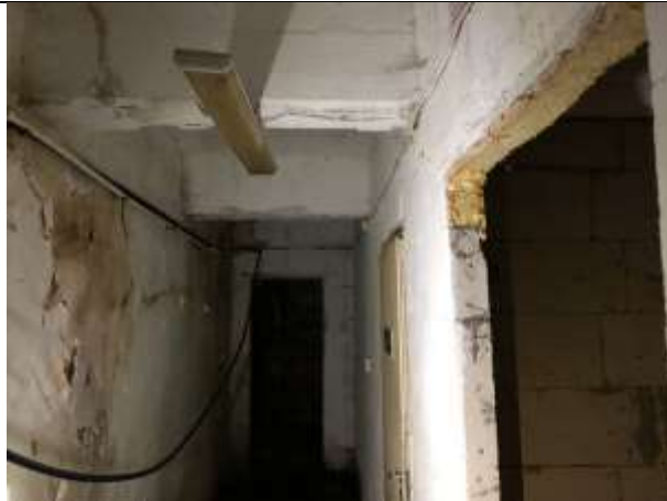
Фото № 39 – Внутреннее состояние помещения
