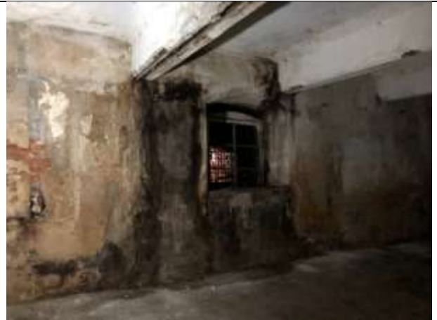
Фото № 16 – Внутреннее состояние помещения
