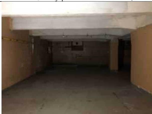
Фото № 45 – Внутреннее состояние помещения
