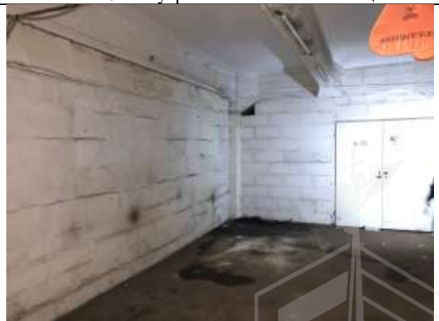
Фото № 22 – Внутреннее состояние помещения
