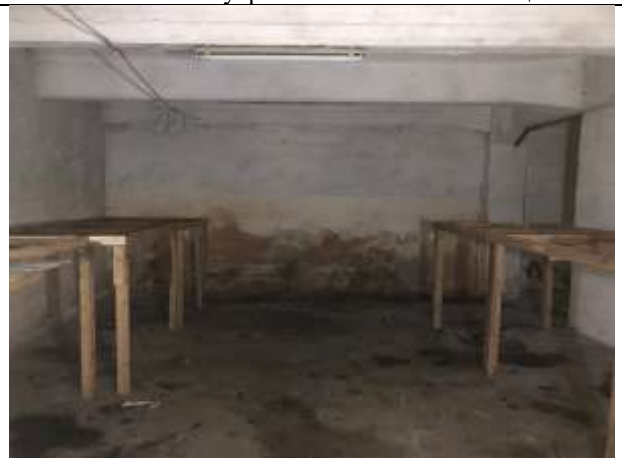
Фото № 20 – Внутреннее состояние помещения
