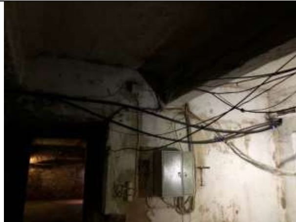
Фото № 40 – Внутреннее состояние помещения
