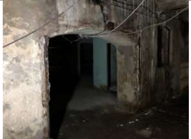
Фото № 18 – Внутреннее состояние помещения
