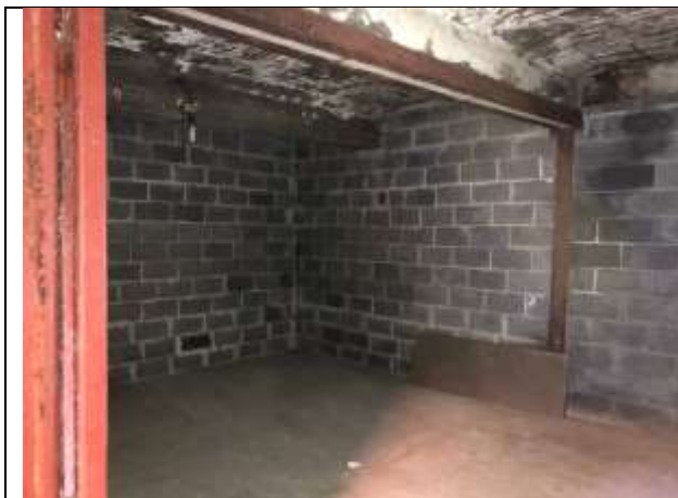
Фото № 47 – Внутреннее состояние помещения
