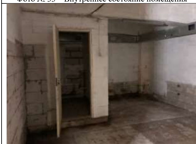
Фото № 35 – Внутреннее состояние помещения
