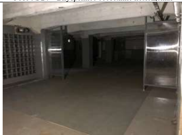
Фото № 26 – Внутреннее состояние помещения
