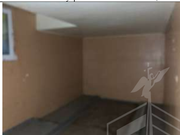
Фото № 46 – Внутреннее состояние помещения
