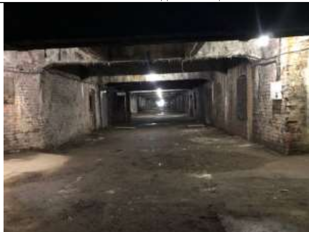
Фото № 9 – Внутреннее состояние помещения
