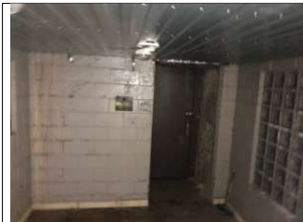
Фото № 31 – Внутреннее состояние помещения
