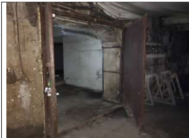
Фото № 23 – Внутреннее состояние помещения
