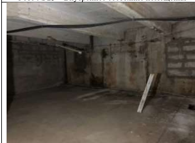
Фото № 25 – Внутреннее состояние помещения
