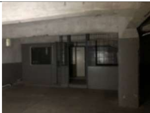
Фото № 48 – Внутреннее состояние помещения
