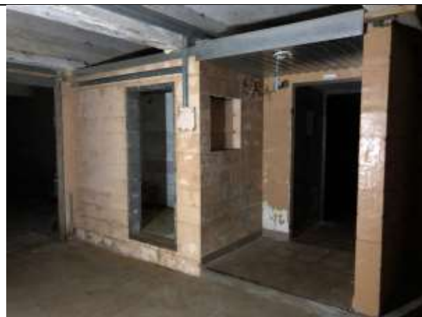
Фото № 32 – Внутреннее состояние помещения
