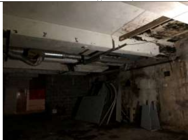
Фото № 10 – Внутреннее состояние помещения
