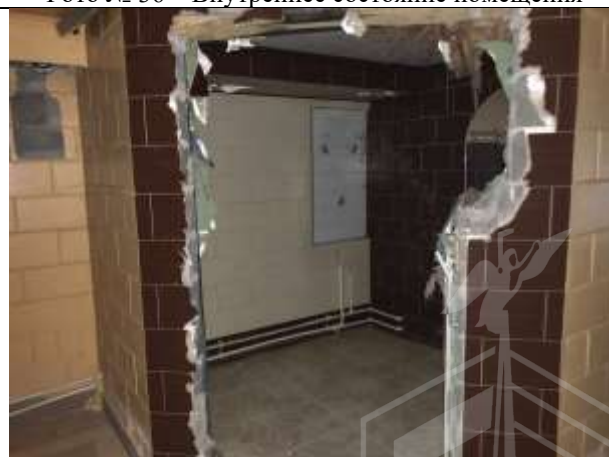
Фото № 38 – Внутреннее состояние помещения
