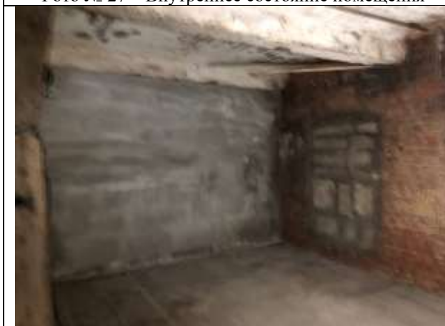
Фото № 29 – Внутреннее состояние помещения
