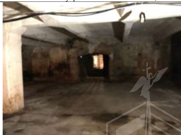
Фото № 14 – Внутреннее состояние помещения
