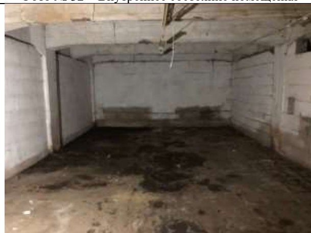
Фото № 34 – Внутреннее состояние помещения
