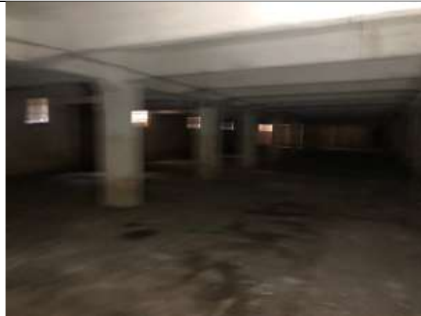
Фото № 15 – Внутреннее состояние помещения
