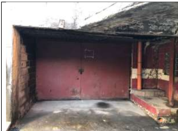
Фото № 7 – Вход в помещение
