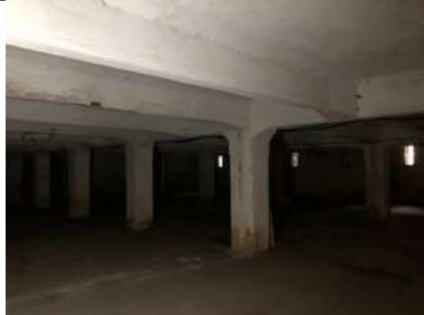
Фото № 17 – Внутреннее состояние помещения
