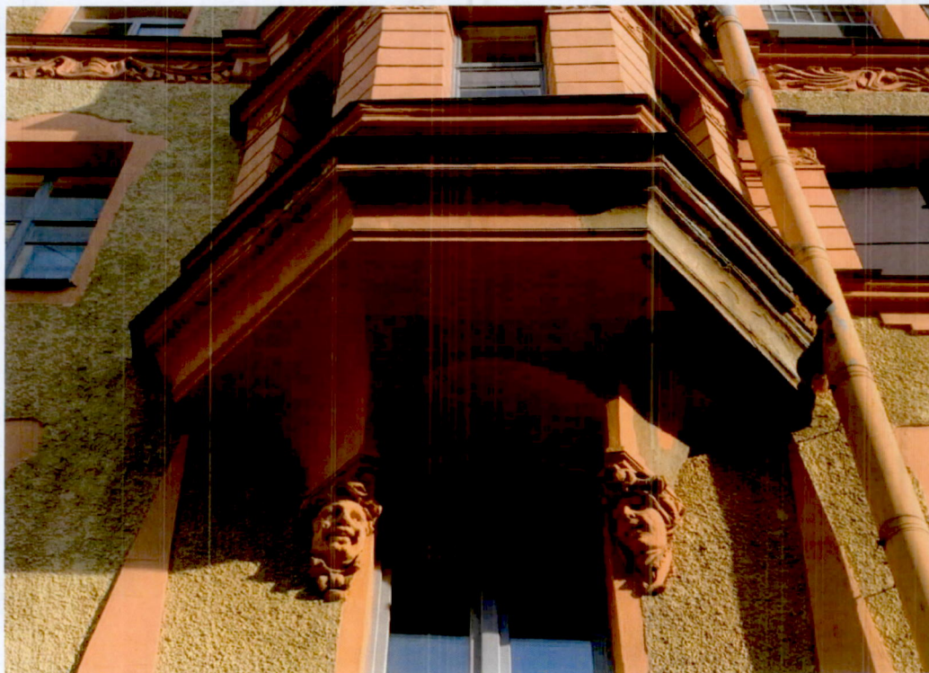
2. Фрагмент эркера с юго-западной стороны (фото от 13.03.2024)
