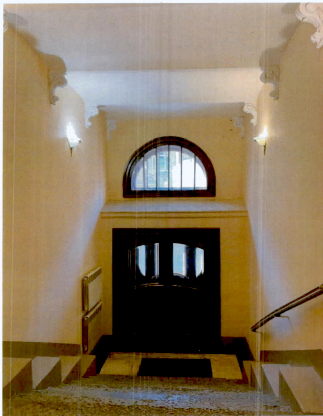
6. Интерьеры. Лестница Л1 (фото от 13.03.2024)
