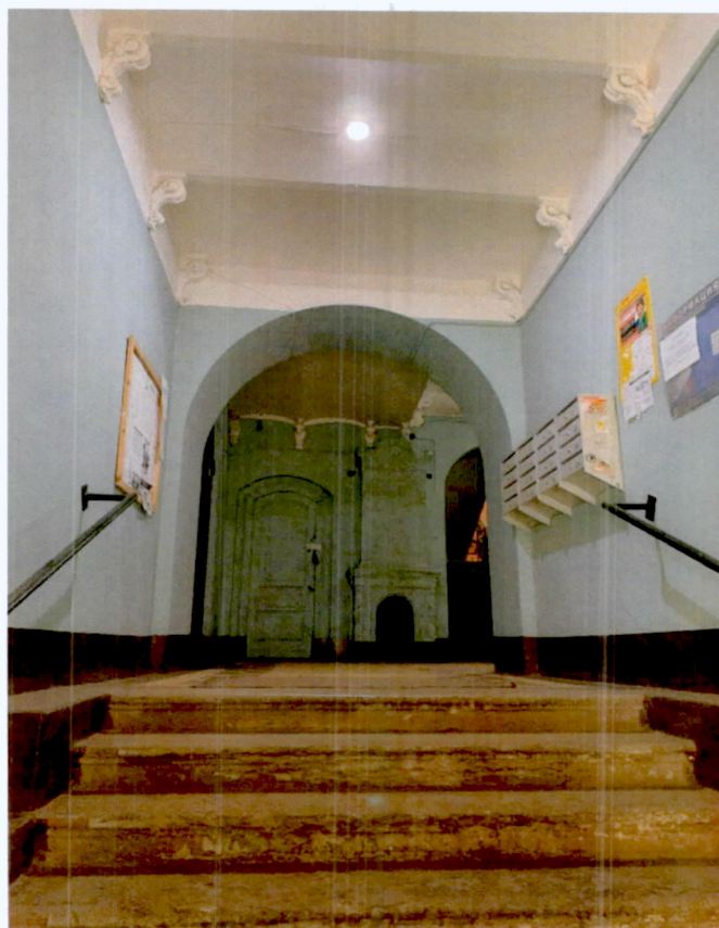
9. Интерьеры. Лестница Л2 (фото от 13.03.2024)
