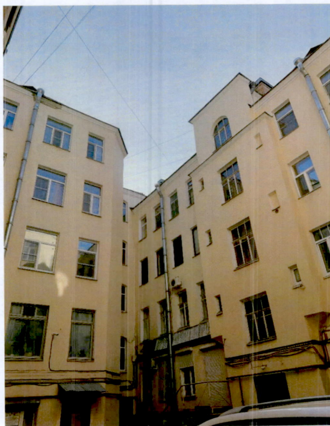
3. Фрагмент дворового фасада (фото от 13.03.2024)
