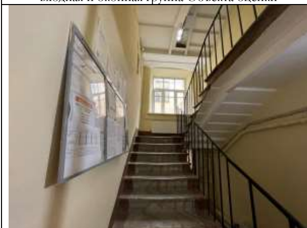
Фото 19. Лестничный проём Объекта оценки
