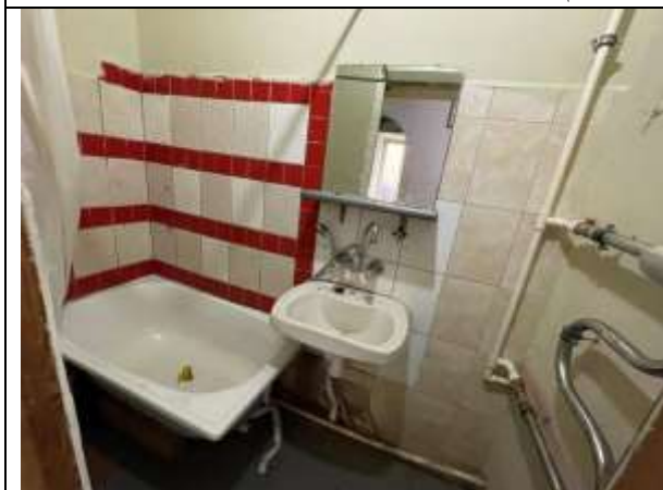
Фото 33. Типичное состояние Объекта оценки
