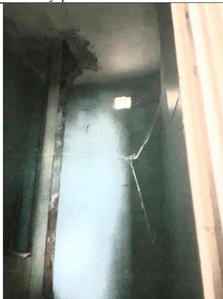
Фото 16. Внутреннее состояние Объекта оценки
