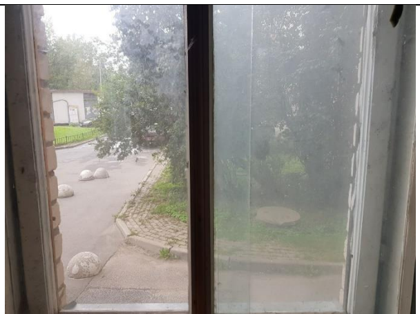
Фото 14. Внутреннее состояние Объекта оценки
