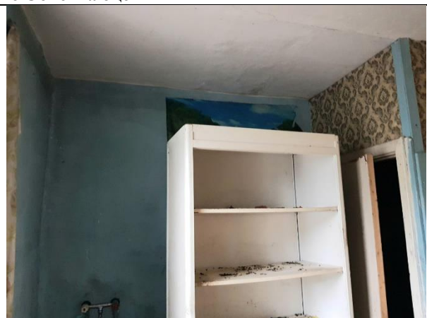
Фото 10. Внутреннее состояние Объекта оценки
