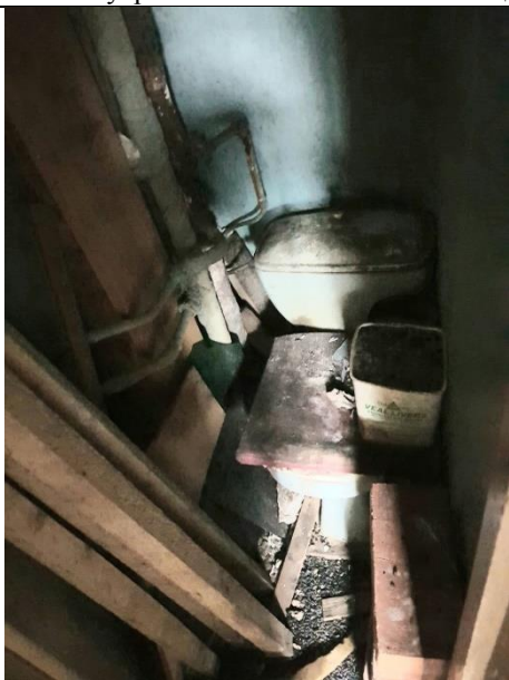
Фото 15. Внутреннее состояние Объекта оценки
