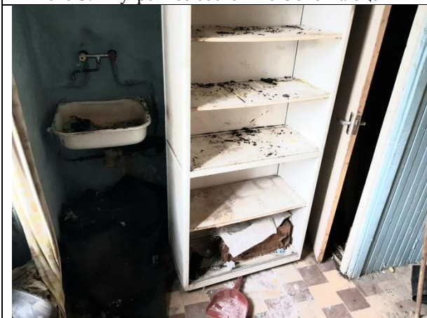
Фото 11. Внутреннее состояние Объекта оценки
