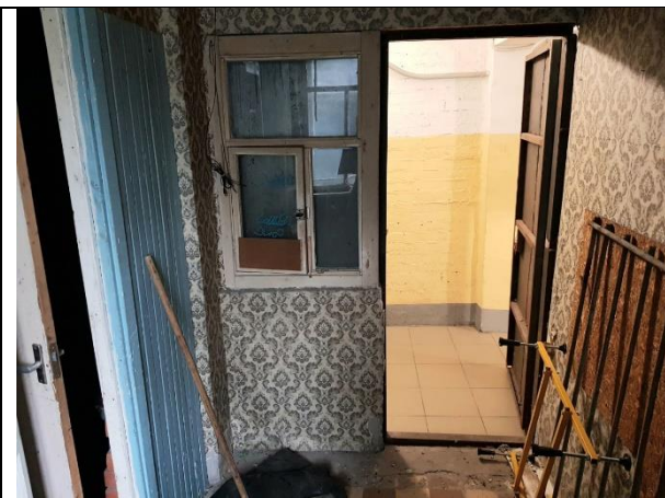
Фото 13. Внутреннее состояние Объекта оценки
