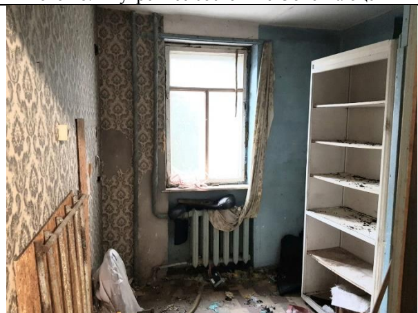
Фото 12. Внутреннее состояние Объекта оценки
