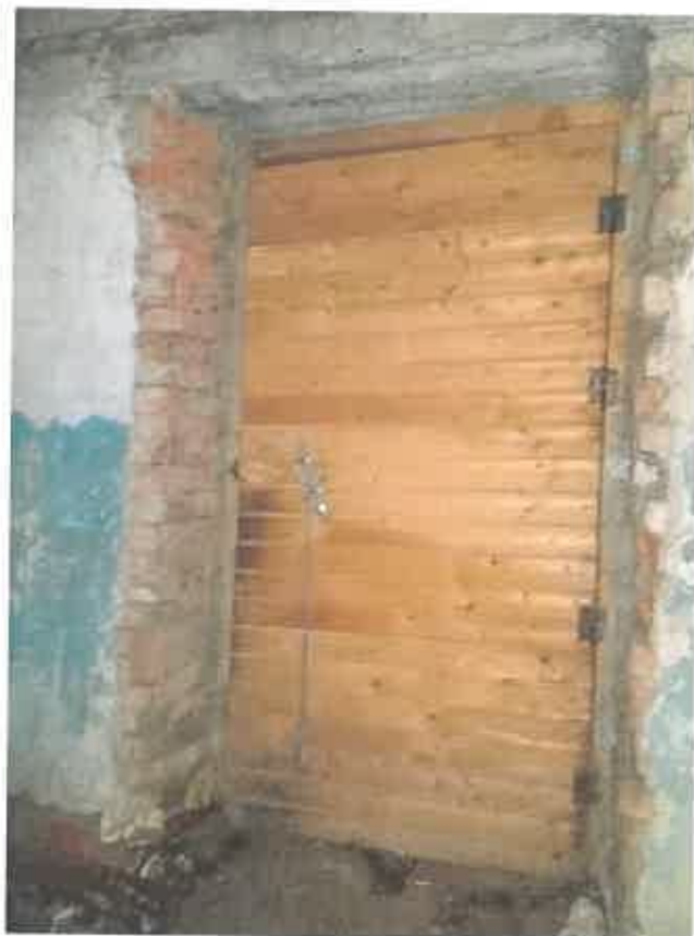
Фото 26. Ч.п.1 (тамбур) пом.1-Н (выход через южный фасад)
