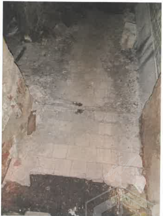
Фото 20. Ч.п.4 пом.1-Н (полы коридора)
