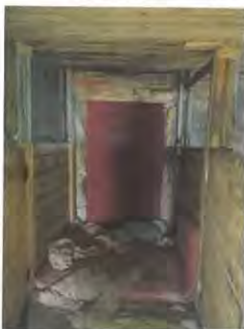
Фото 30. Вход в ч.п.9 (конюшня) пом. I-Н со стороны помещений самовольной деревянной пристройки к восточному фасаду Объекта
