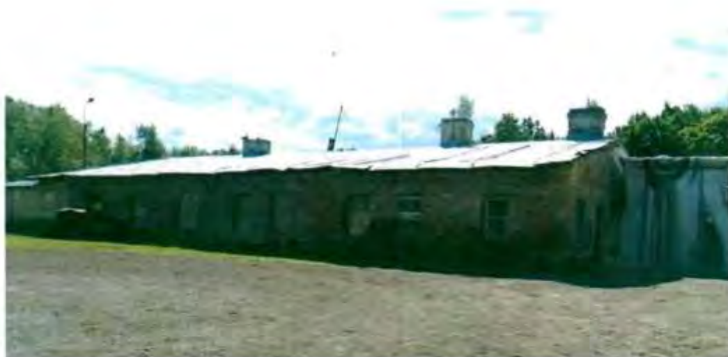
1. Общий вид с северо-запада.
