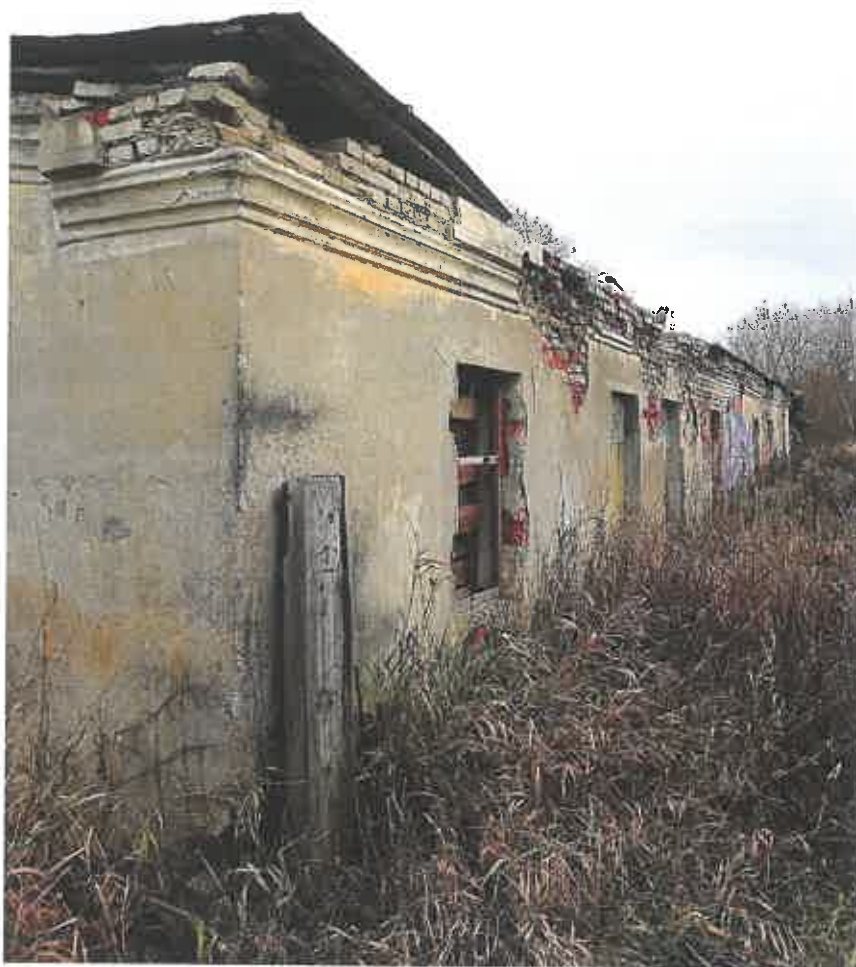
Фото 9. Угол западного и южного фасадов
