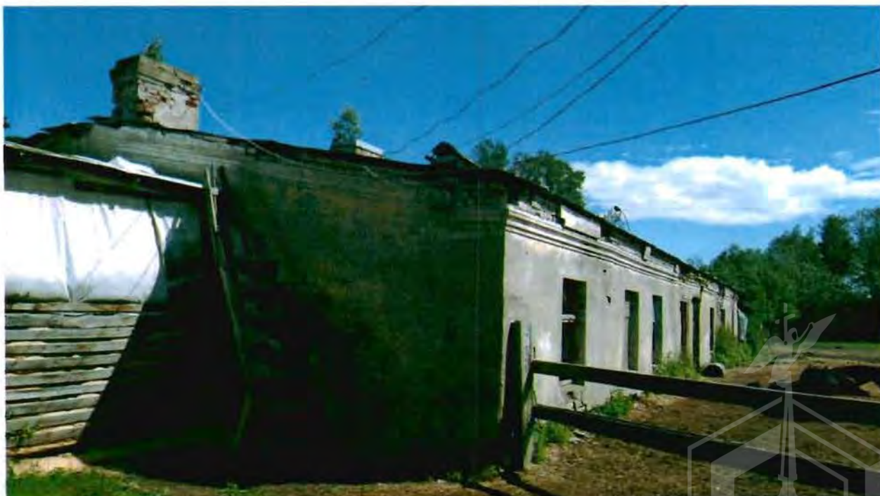
2. Вид с юго-запада.
