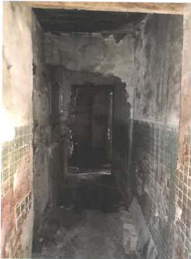
Фото 19. Ч.п.4 пом.1-Н (коридор)
