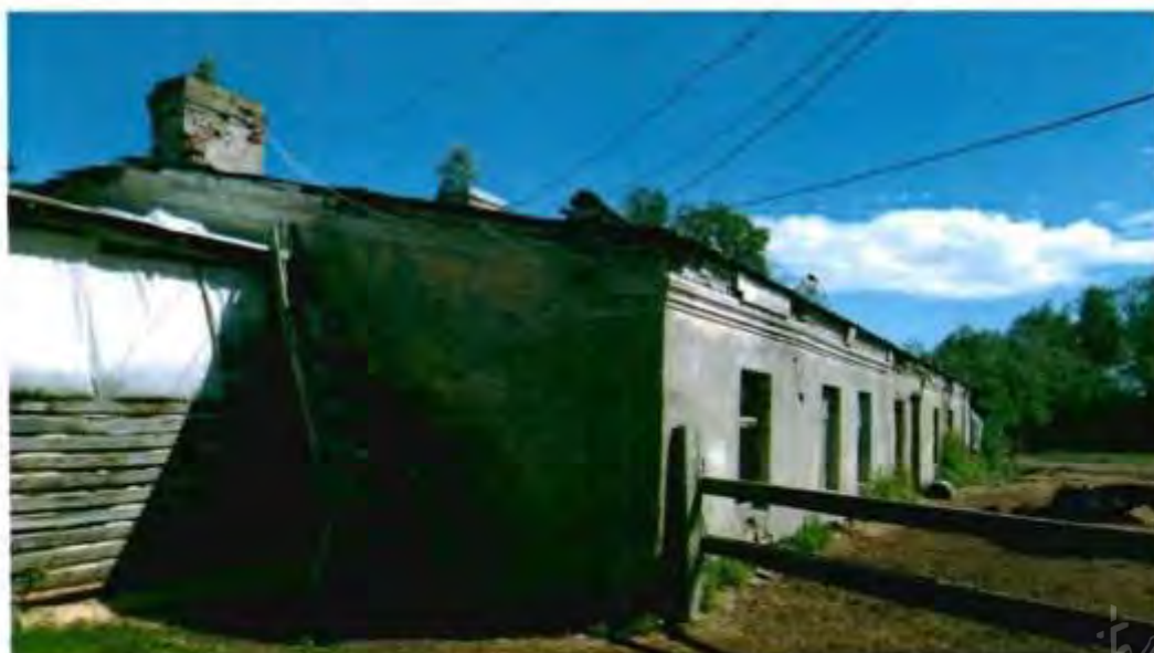
2. Вид с юго-запада.
