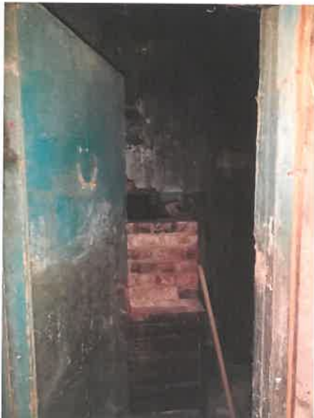
Фото 23. Вход в ч.п.5 (хоз.помещение) пом.1-Н
