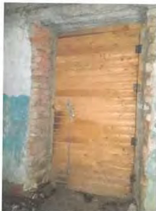
Фото 26. Ч.п.1 (тамбур) пом.1-Н (выход через южный фасад)
