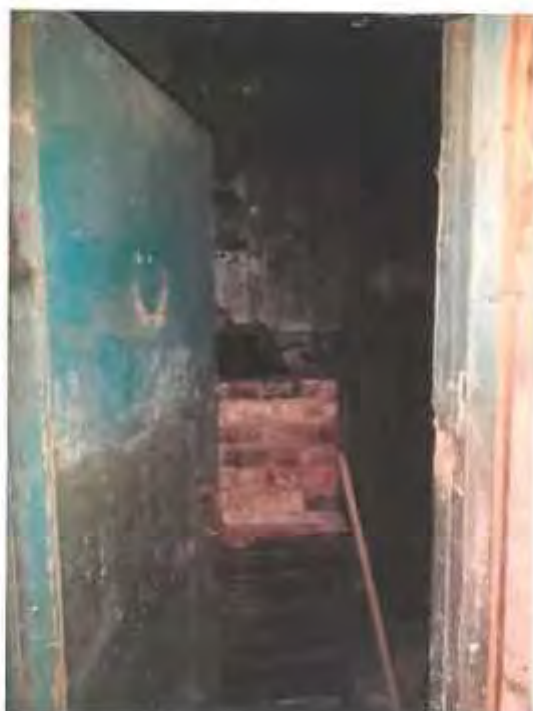
Фото 23. Вход в ч.п.5 (хоз.помещение) пом.1-Н
