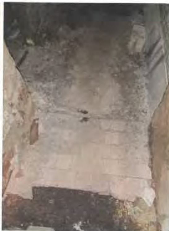
Фото 20. Ч.п.4 пом.1-Н (полы коридора)
