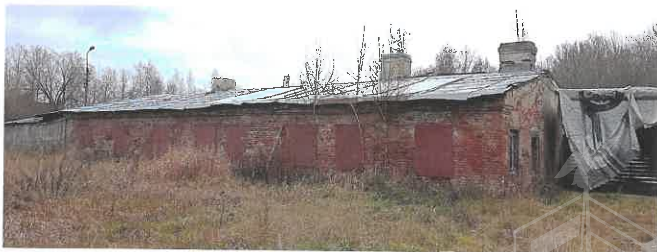
Фото 4. Фасады: северный и часть западного
