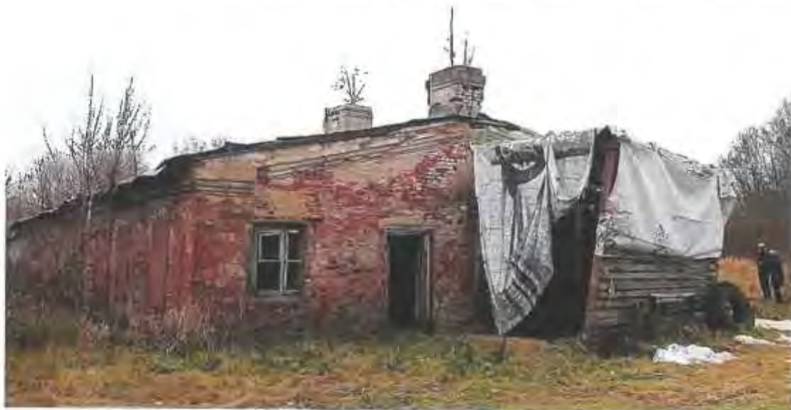
Фото 5. Угол северного и западного фасадов
