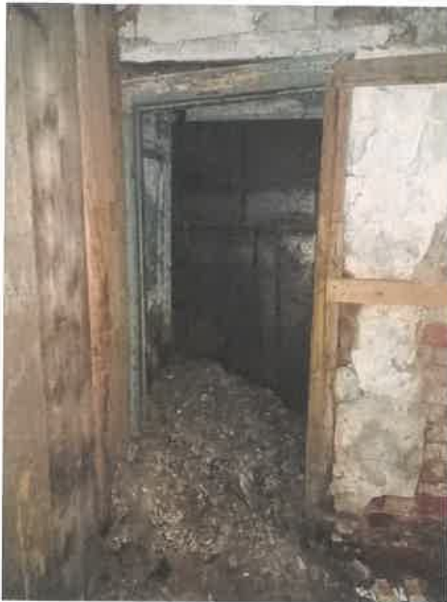
Фото 21. Ч.п.9 (конюшня) пом.1-Н (выход ч/з восточный фасад)
