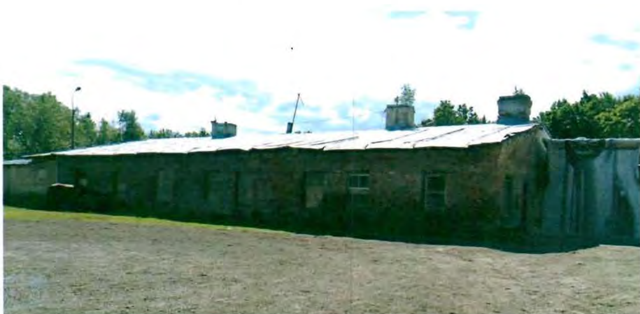
1. Общий вид с северо-запада.
