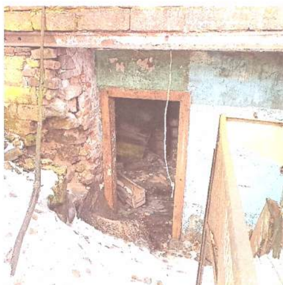
Фото 5. Вид на Дверной просм в уровне подвала (северный фасад)
