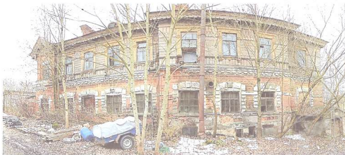
Фото 6. Панорамный вид на восточный фасад
