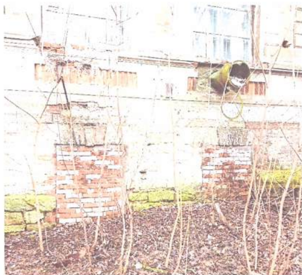
Фото 20. Вид на часть западного фасада
