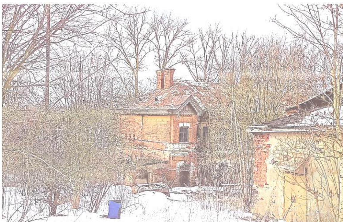
Фото 16. Вид на южный и часть восточного фасадов
