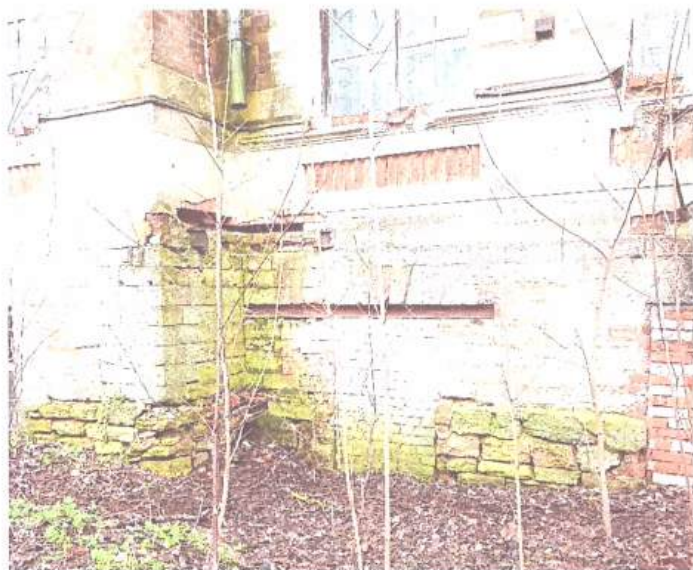
Фото 19. Вид на часть западного фасада
