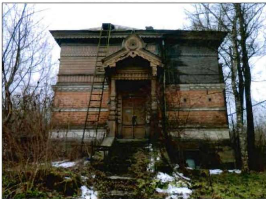
4. «Павильон минеральных вод Верландера». Северный фасад.
