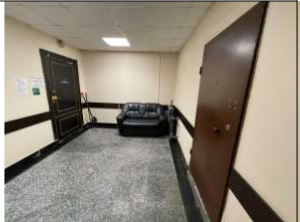
Фото 18. Типичное состояние Объекта оценки
