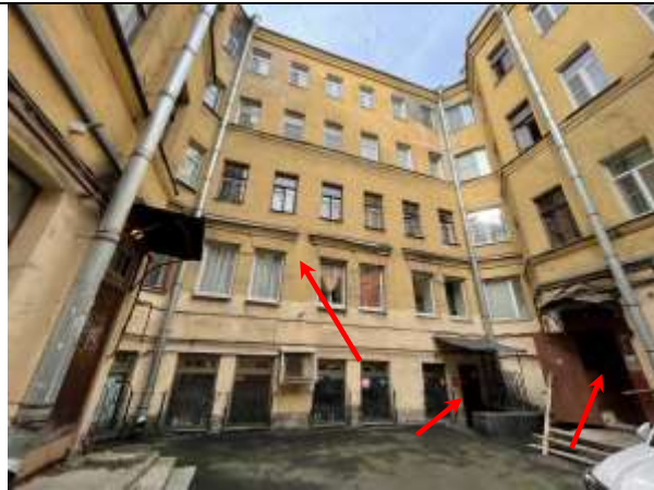
Фото 15. Вид здания расположения Объекта оценки, входная группа Объекта оценки
