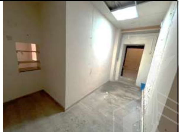
Фото 20. Типичное состояние Объекта оценки
