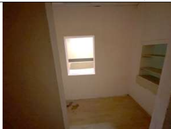
Фото 26. Типичное состояние Объекта оценки
