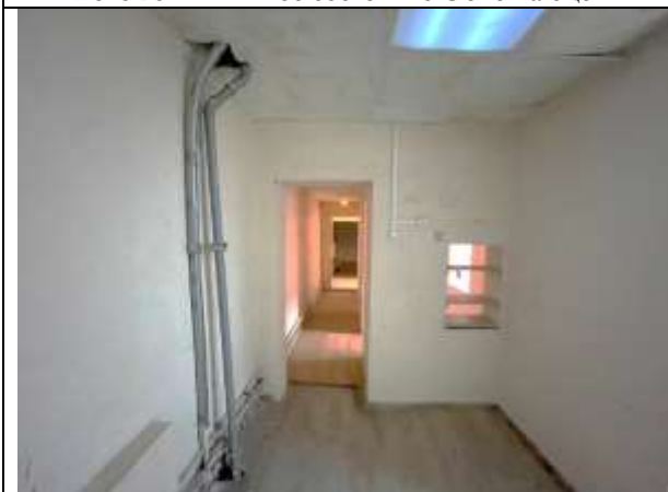
Фото 27. Типичное состояние Объекта оценки
