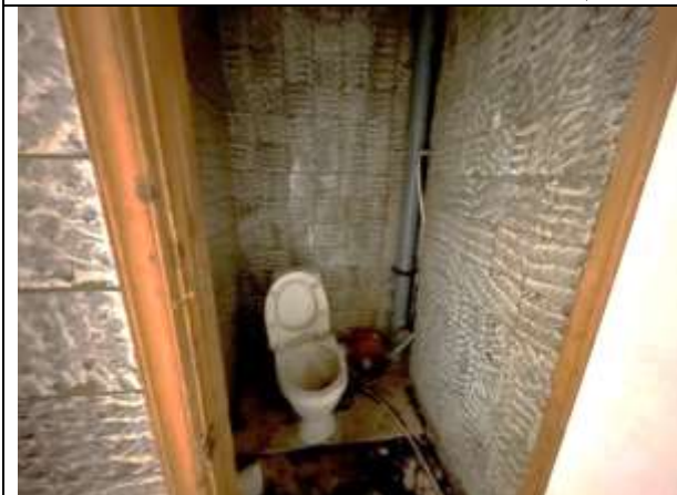
Фото 35. Типичное состояние Объекта оценки
