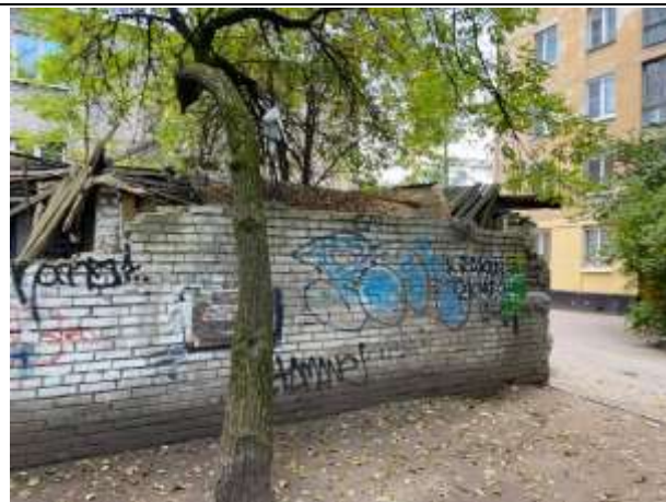
Фото № 6. Внешний вид здания
