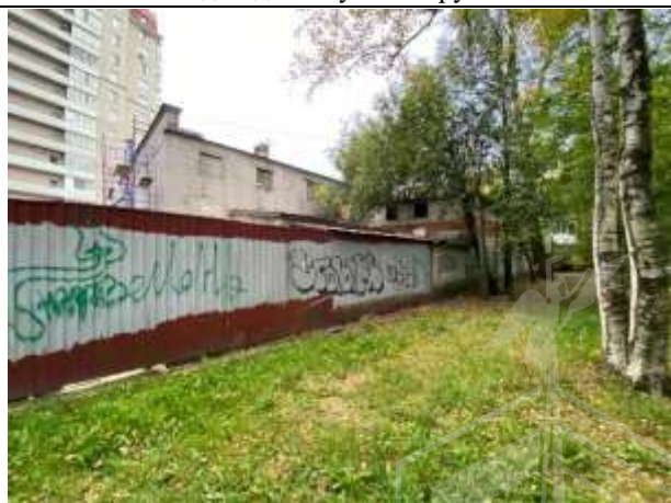
Фото № 4. Внешний вид здания
