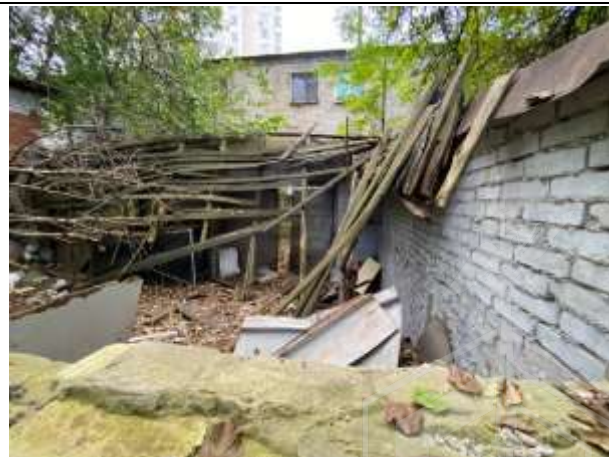
Фото № 12. Внутреннее состояние здания
