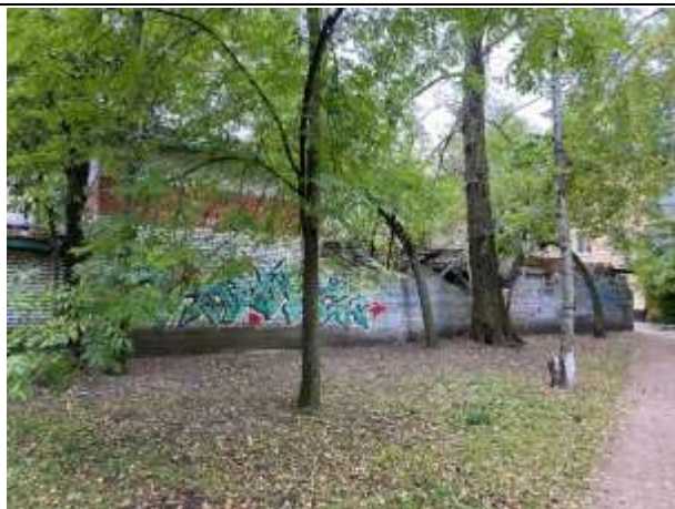
Фото № 5. Внешний вид здания
