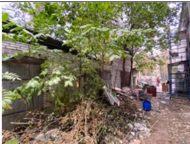
Фото № 9. Внешний вид здания
