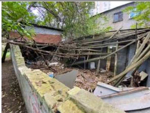
Фото № 11. Внутреннее состояние здания
