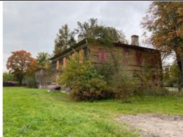
Фото № 4. Внешний вид здания
