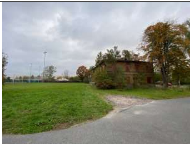
Фото № 1.Подъездные пути и окружение объекта
