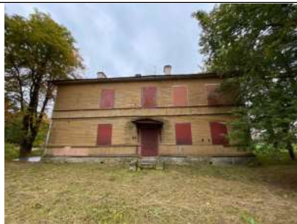
Фото № 6. Внешний вид здания
