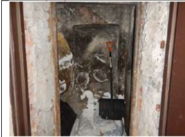
Фото № 7 – Внутреннее состояние помещения*
