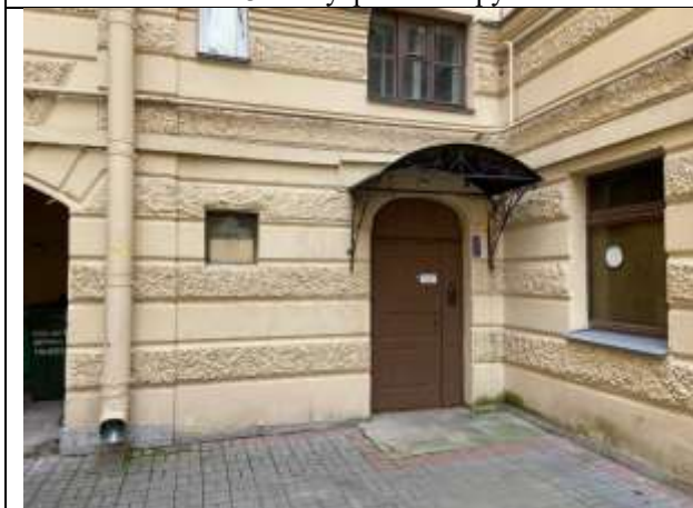
Фото № 5 – Вход в помещение со двора
