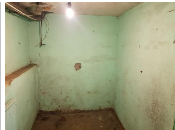
Фото 13. Внутреннее состояние Объекта оценки
