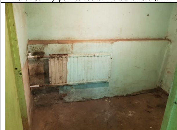
Фото 15. Внутреннее состояние Объекта оценки
