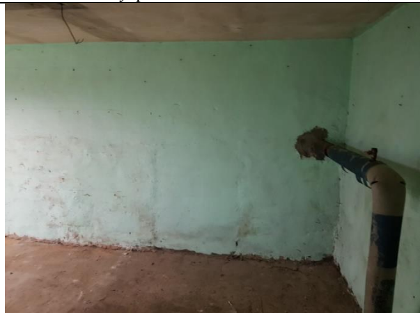
Фото 12. Внутреннее состояние Объекта оценки
