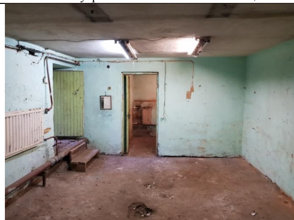
Фото 9. Внутреннее состояние Объекта оценки
