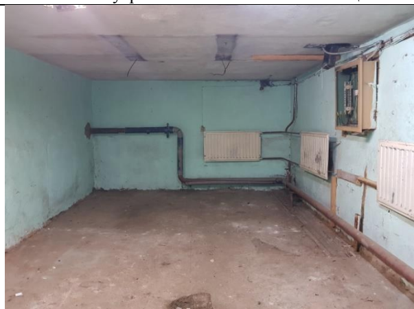
Фото 10. Внутреннее состояние Объекта оценки
