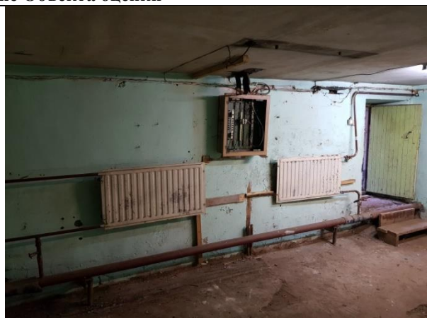
Фото 8. Внутреннее состояние Объекта оценки
