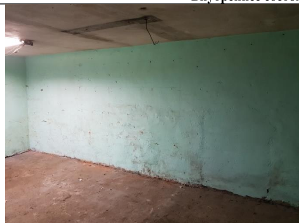
Фото 7. Внутреннее состояние Объекта оценки
