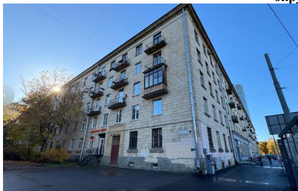
Фото 1. Вид здания Объекта оценки
