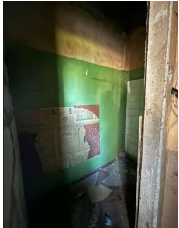
Фото 30. Типичное состояние Объекта оценки
