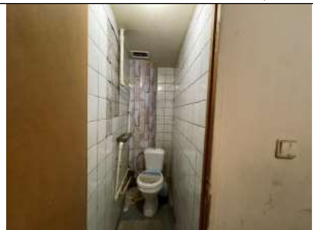
Фото 34. Типичное состояние Объекта оценки
