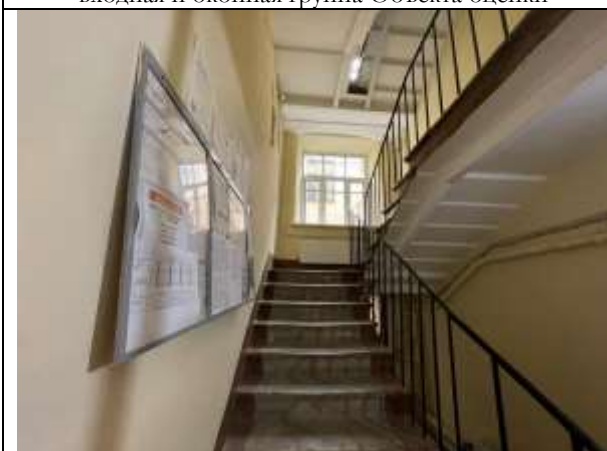
Фото 19. Лестничный проём Объекта оценки
