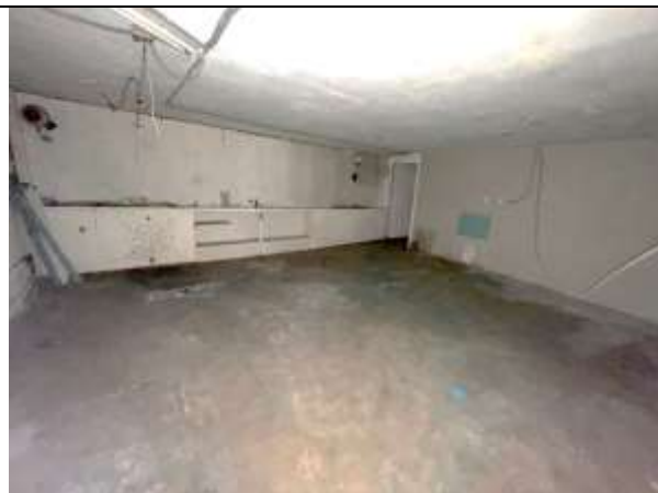
Фото 39. Типичное состояние Объекта оценки
