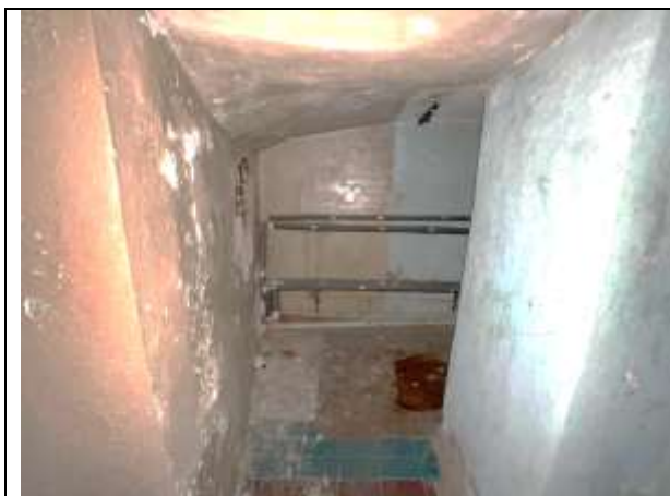
Фото 63. Типичное состояние Объекта оценки
