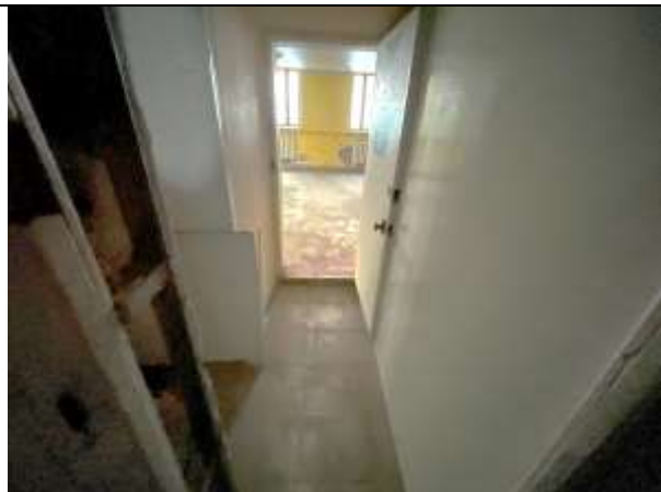
Фото 42. Типичное состояние Объекта оценки
