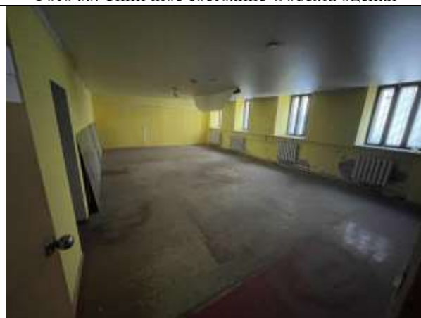
Фото 35. Типичное состояние Объекта оценки
