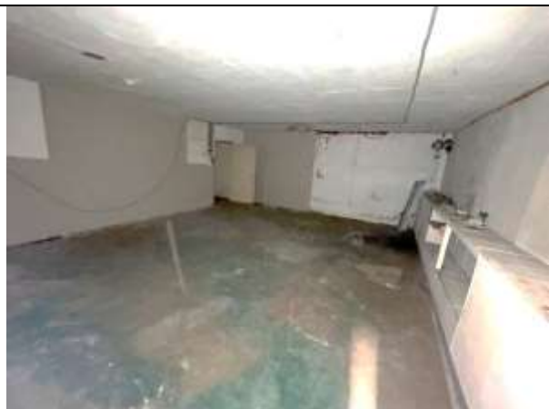
Фото 40. Типичное состояние Объекта оценки
