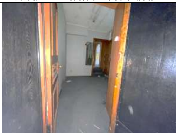
Фото 91. Типичное состояние Объекта оценки
