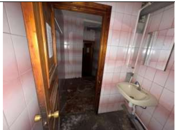
Фото 120. Типичное состояние Объекта оценки
