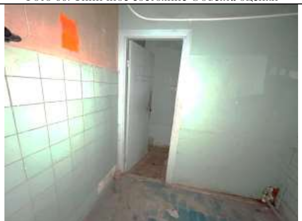
Фото 68. Типичное состояние Объекта оценки
