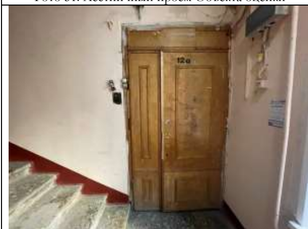
Фото 53. Лестничный проём Объекта оценки
