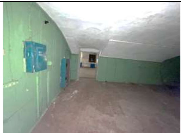
Фото 58. Типичное состояние Объекта оценки
