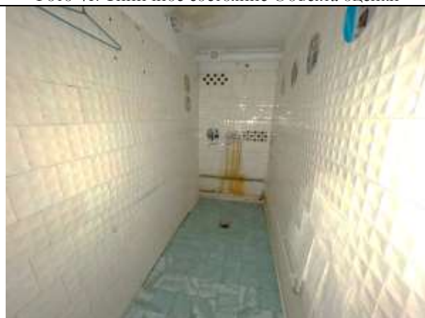
Фото 43. Типичное состояние Объекта оценки
