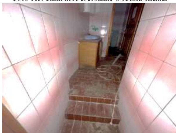
Фото 117. Типичное состояние Объекта оценки
