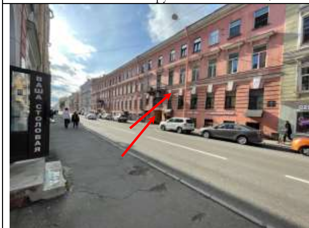
Фото 17. Вид здания расположения Объекта оценки
