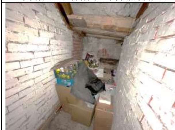
Фото 75. Типичное состояние Объекта оценки
