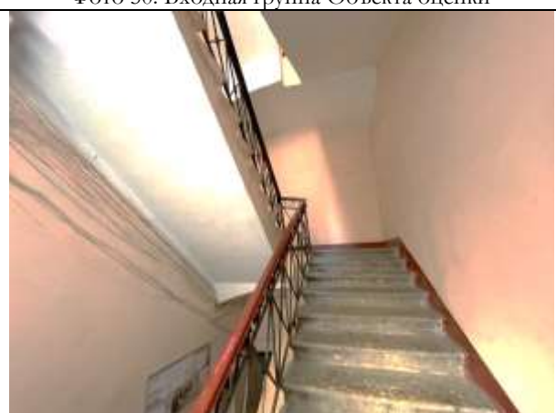
Фото 52. Лестничный проём Объекта оценки
