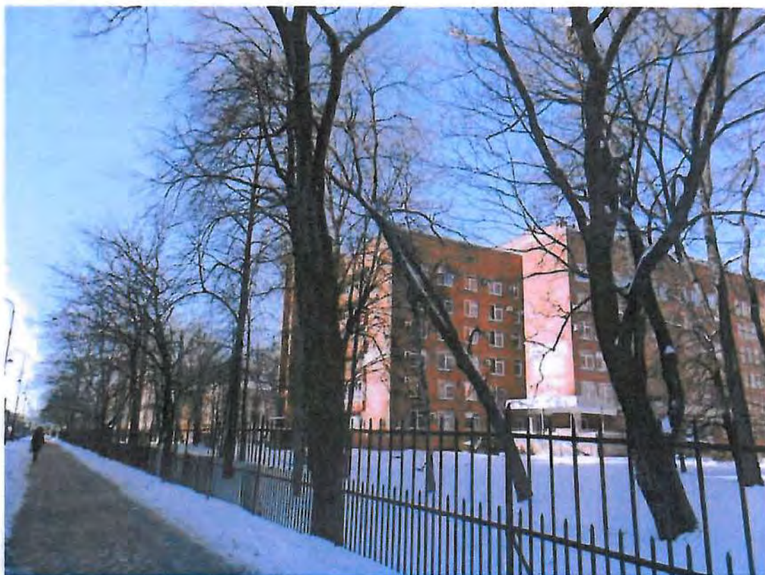
16. Ограда со стороны Большого проспекта
