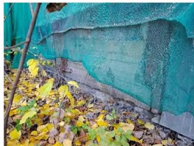
Фото 16. Вид на фрагмент юго-западного фасада
