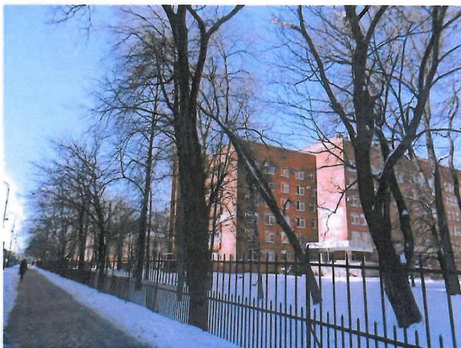
16. Ограда со стороны Большого проспекта
