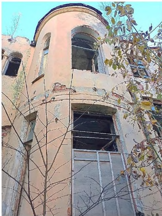
Фото 32. Вид на оконные проемы ч.п.93 и 131 пом.1-Н (северо-западный фасад)
