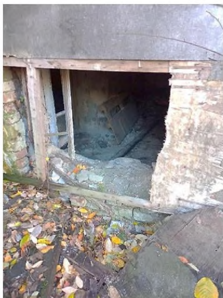
Фото 26. Вид на оконный проем ч.п.28 пом.1-Н (один из дворовых фасадов)
