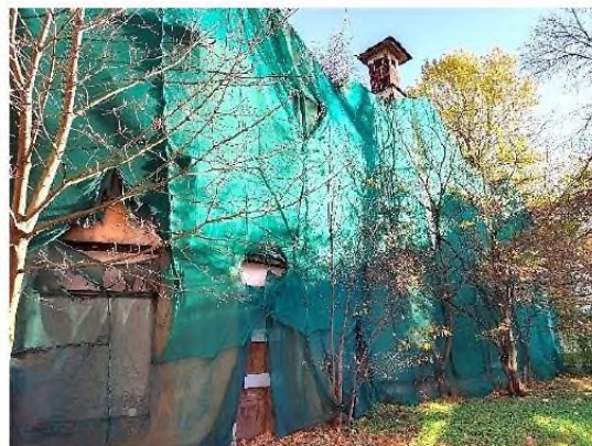
Фото 18. Вид на фрагмент юго-западного фасада
