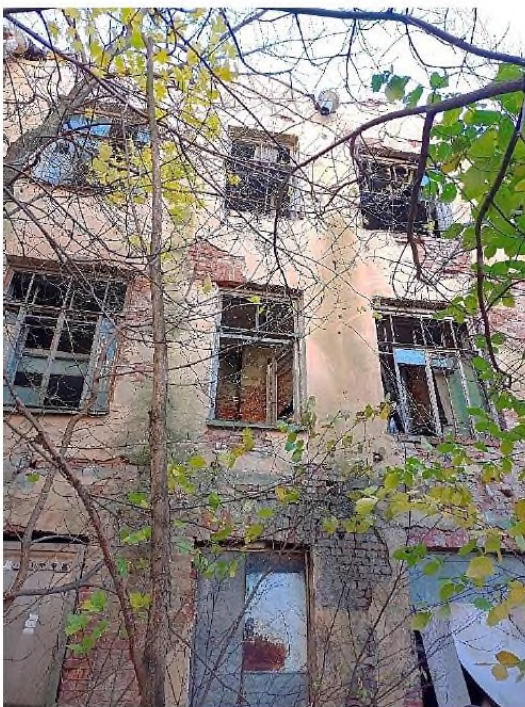
Фото 34. Вид на фрагмент северо-западного фасада
