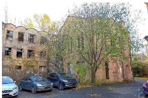
Фото 41. Вид на фрагмент внутреннего двора
