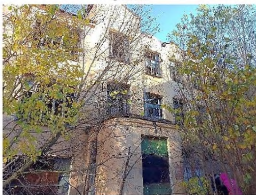
Фото 38. Вид на фрагмент одного из дворовых фасадов, на вход в ч.п.55 пом.1-Н
