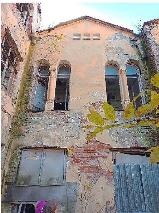
Фото 24. Вид на оконные проемы ч.п.28, 88, 84 пом.1-Н (один из дворовых фасадов)
