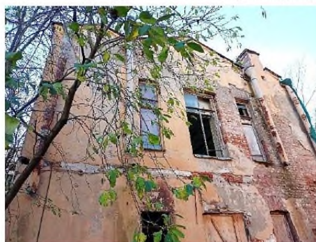
Фото 20. Вид на фрагмент северо-западного фасада
