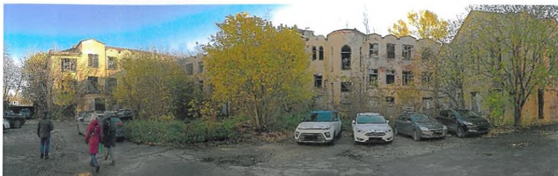
Фото 42. Панорамный вид на внутренний двор
