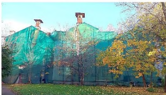
Фото 17. Вид на юго-западный фасад
