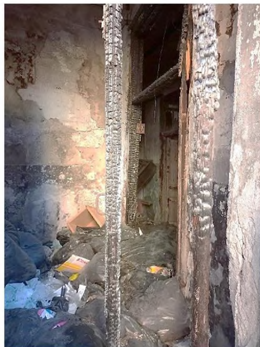
Фото 23. Вид через оконный проем ч.п.25 пом.1-Н (северо-западный фасад)
