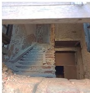
Фото 31. Вид на фрагмент лестничного марша через оконный проем (северо-западный фасад)
