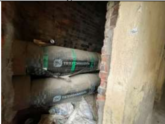
Фото 23. Типичное состояние Объекта оценки
