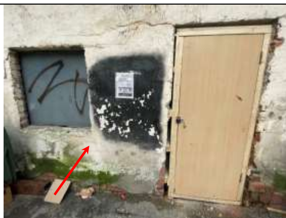
Фото 20. Входная и оконная группа Объекта оценки
