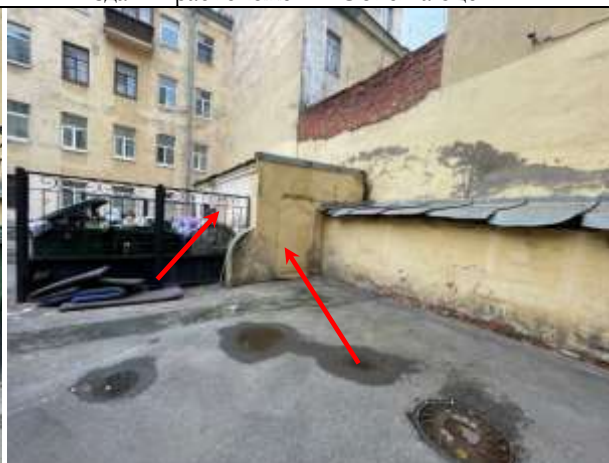
Фото 18. Входная и оконная группа Объекта оценки
