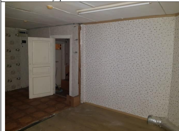
Фото 13. Внутреннее состояние Объекта оценки
