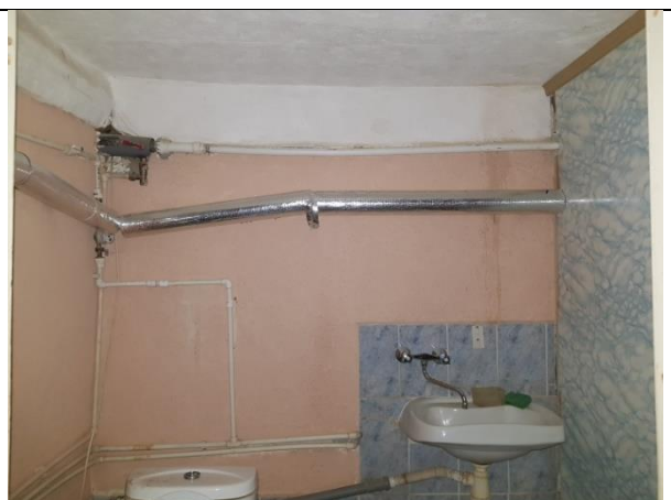
Фото 20. Внутреннее состояние Объекта оценки
