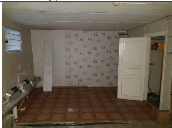
Фото 14. Внутреннее состояние Объекта оценки
