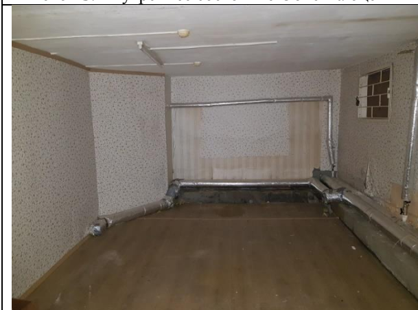
Фото 15. Внутреннее состояние Объекта оценки
