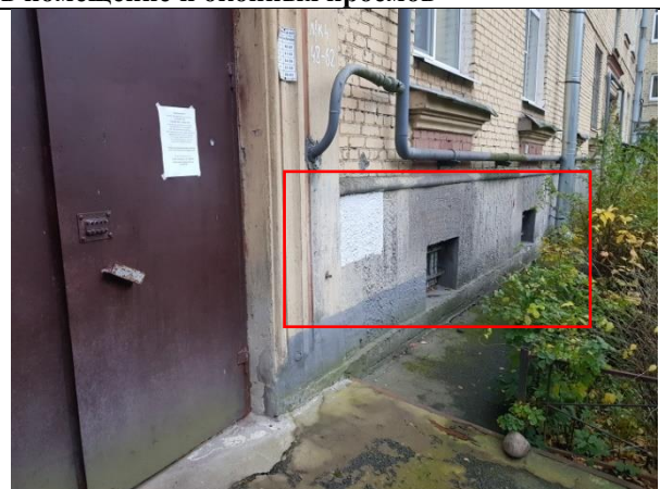
Фото 6. Вид окон Объекта оценки
