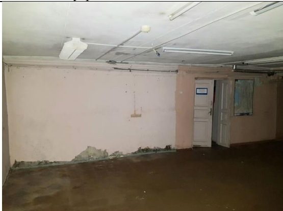
Фото 15. Внутреннее состояние Объекта оценки
