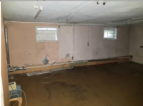
Фото 17. Внутреннее состояние Объекта оценки
