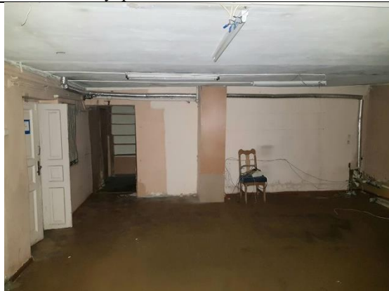
Фото 16. Внутреннее состояние Объекта оценки
