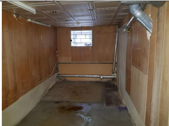
Фото 14. Внутреннее состояние Объекта оценки
