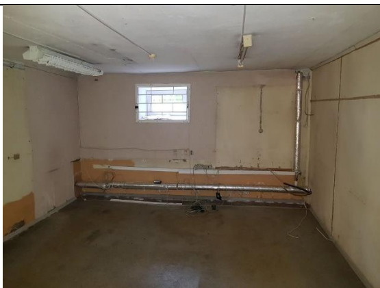
Фото 11. Внутреннее состояние Объекта оценки
