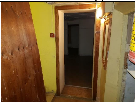
Фото 9. Внутреннее состояние Объекта оценки
