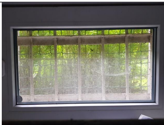
Фото 12. Внутреннее состояние Объекта оценки
