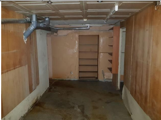
Фото 13. Внутреннее состояние Объекта оценки
