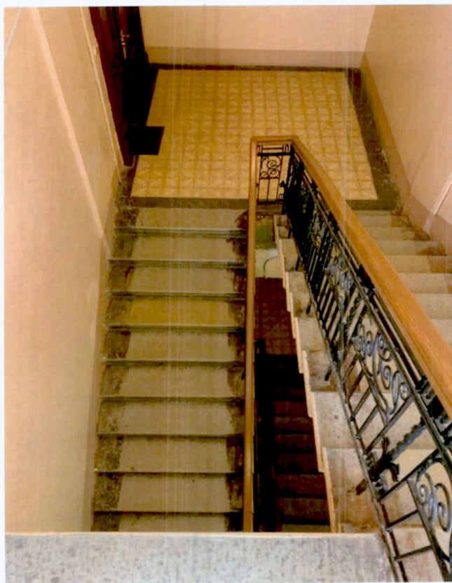
7. Интерьеры. Лестница Л1 (фото от 13.03.2024)
