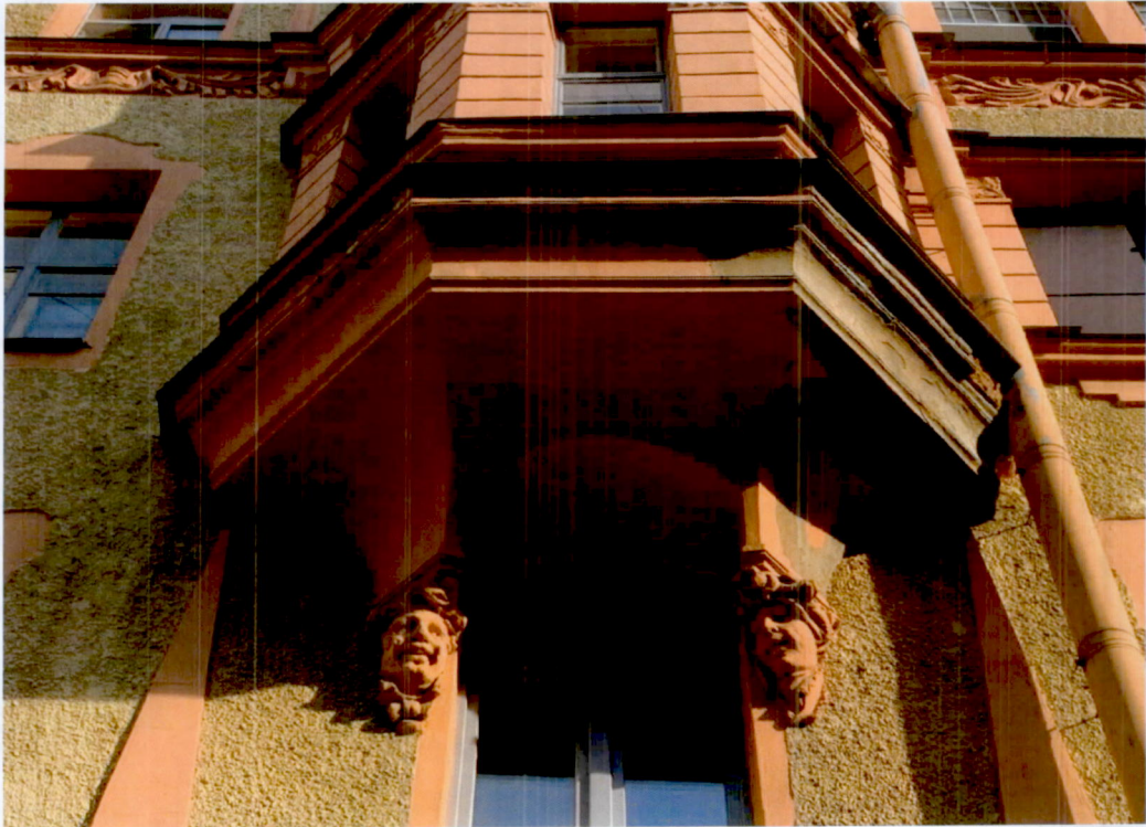
2. Фрагмент эркера с юго-западной стороны (фото от 13.03.2024)
