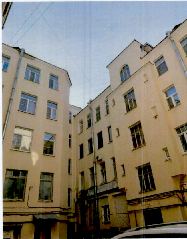
3. Фрагмент дворового фасада (фото от 13.03.2024)
