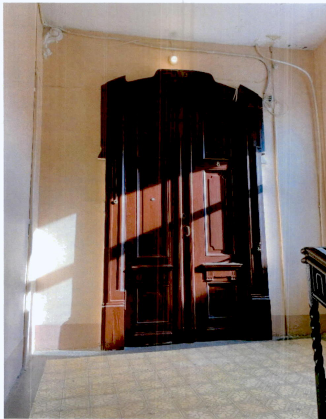
8. Интерьеры. Лестница Л1 (фото от 13.03.2024)
