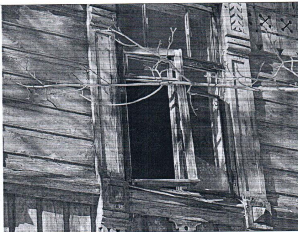
Описание: Вид на Объект
