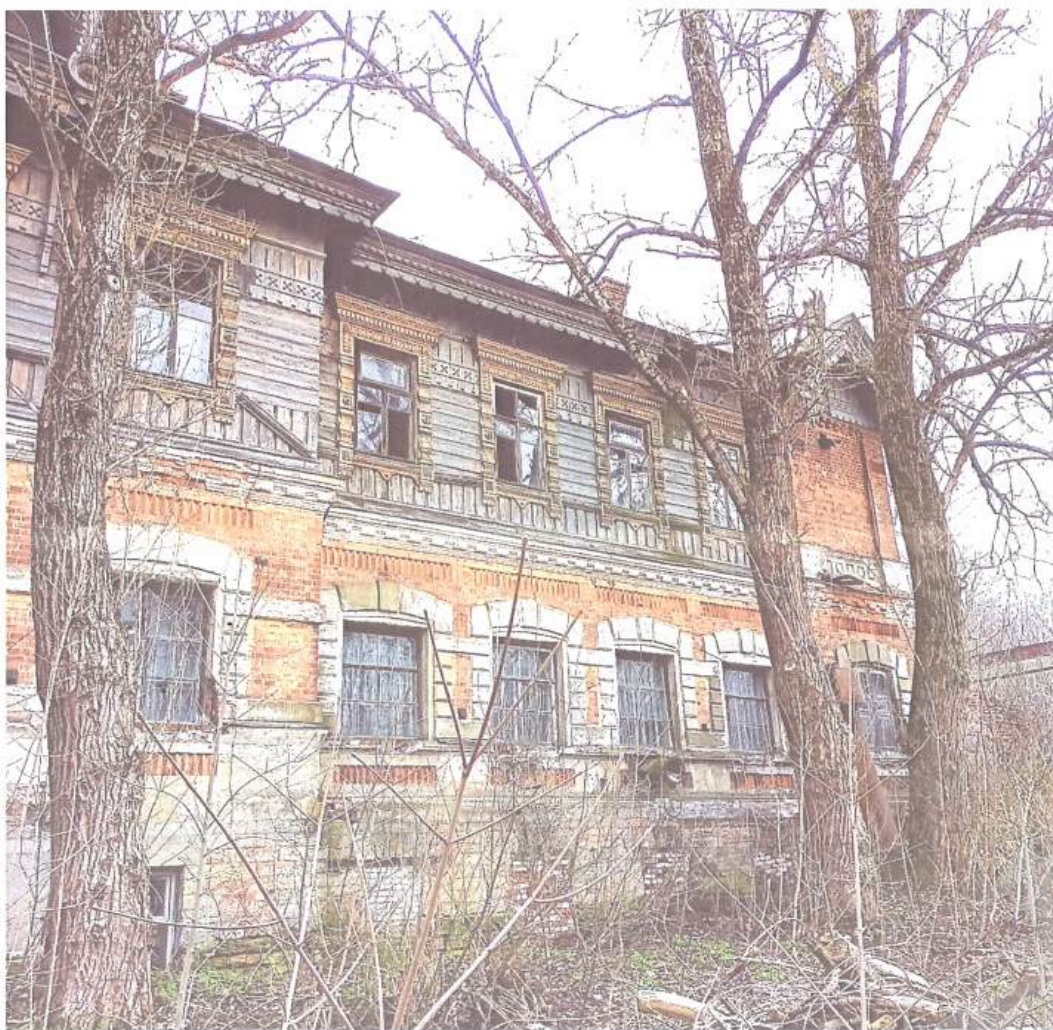
Фото 18. Вид на часть западного фасада
