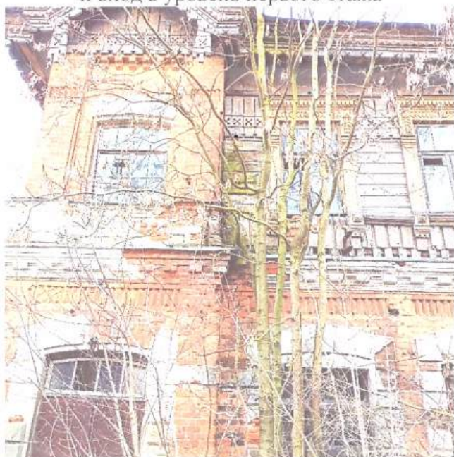
Фото 10. Вид на часть восточного фасада
