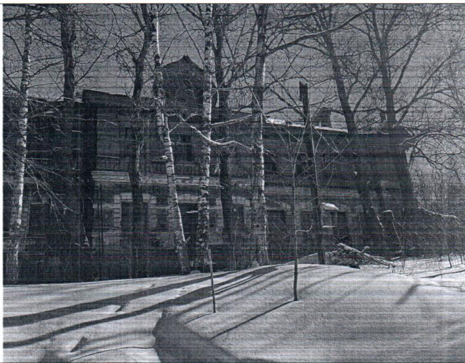
Описание: Вид на Объект
