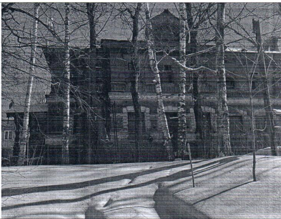
Описание: Вид на Объект
