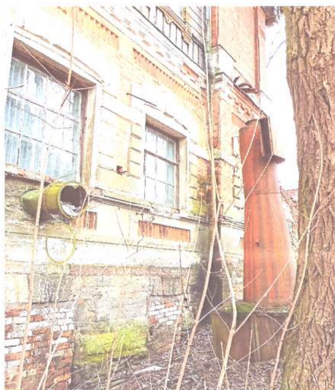
Фото 21. Вид на часть западного фасада
