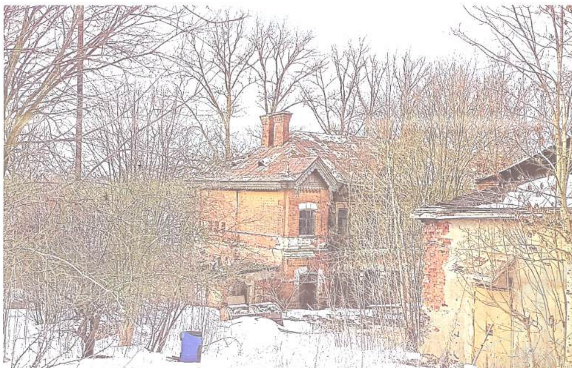
Фото 16. Вид на южный и часть восточного фасадов
