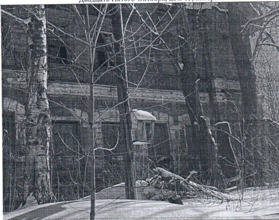
Описание: Вид на Объект
