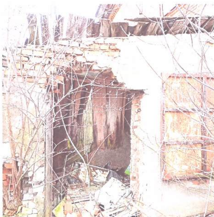
Фото 12. Вид на часть восточного фасада и крайний левый вход в уровень первого этажа
