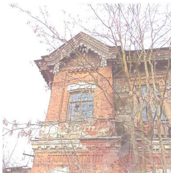
Фото 11. Вид на часть восточного фасада
