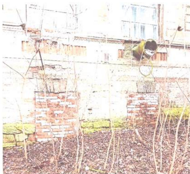
Фото 20. Вид на часть западного фасада
