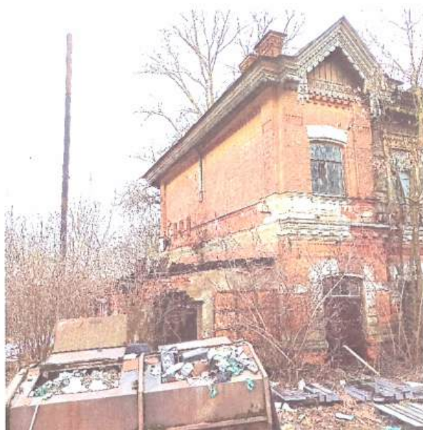
Фото 13. Вид на часть южного и восточного фасадов
