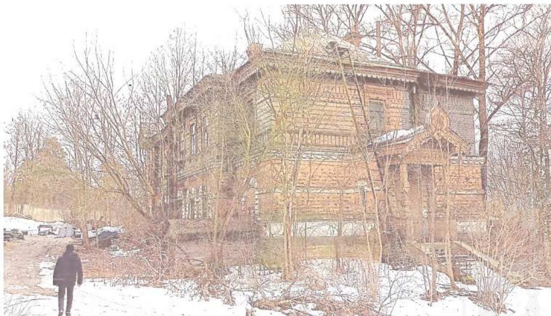
Фото 1. Вид на восточный и северный и фасады, главный вход
