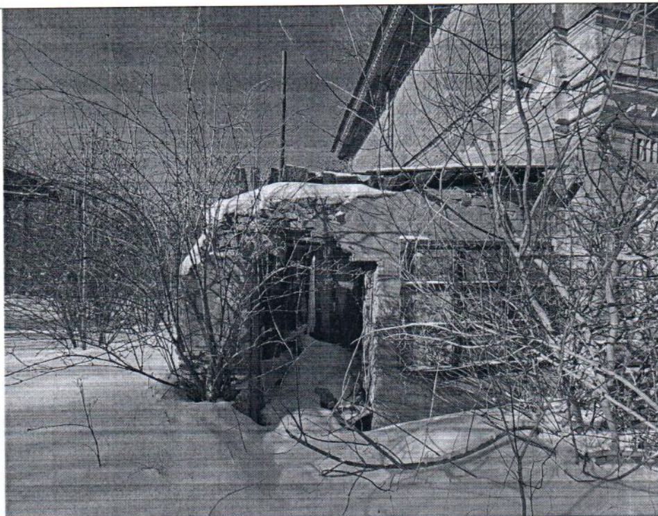
Описание: Вид на Объект
