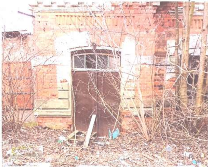
Фото 8. Вид на часть восточного фасада и вход в уровень первого этажа
