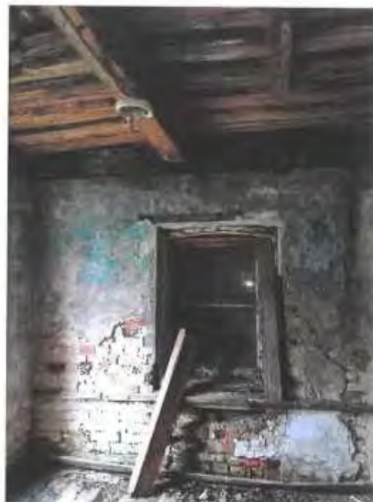
Фото 14. Ч.п.6 (конюшня) пом.1-Н
