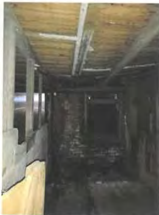
Фото 18. Ч.п.8 (конюшня) пом.1-Н
