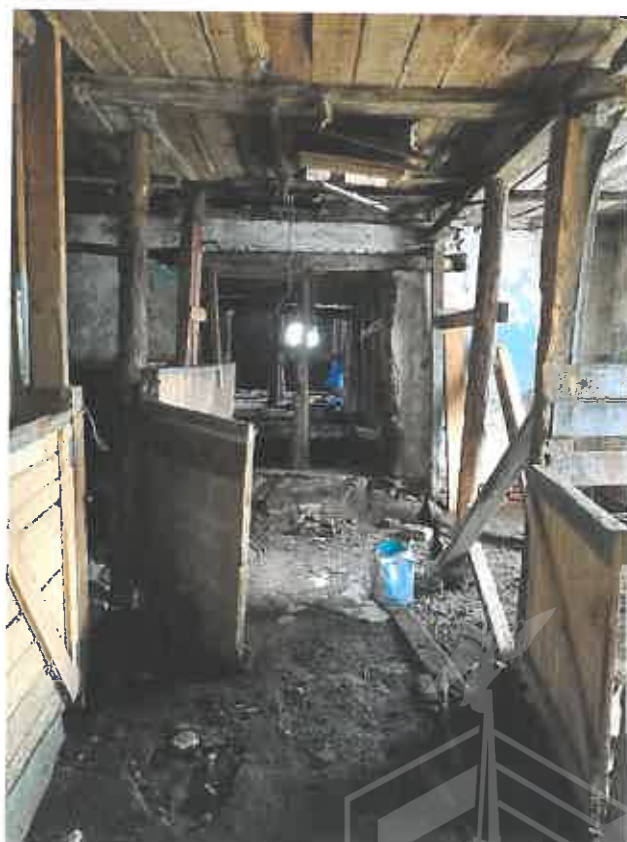
Фото 28. Ч.п.2 (конюшня) пом.1-Н
