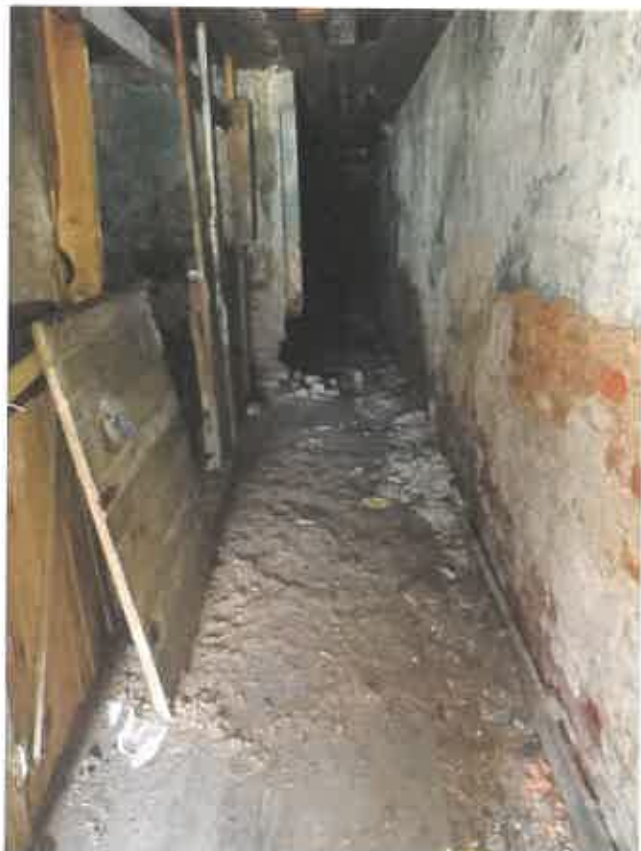
Фото 15. Ч.п.6 (конюшня) пом.1-Н
