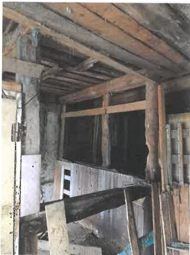
Фото 13. Ч.п.6 (конюшня) пом.1-Н
