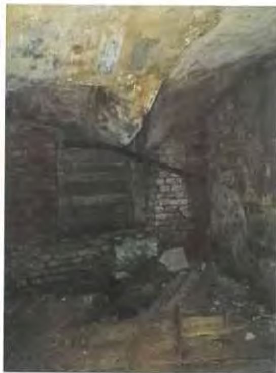
Фото 22. Ч.п.9 (конюшня) пом.1-Н
