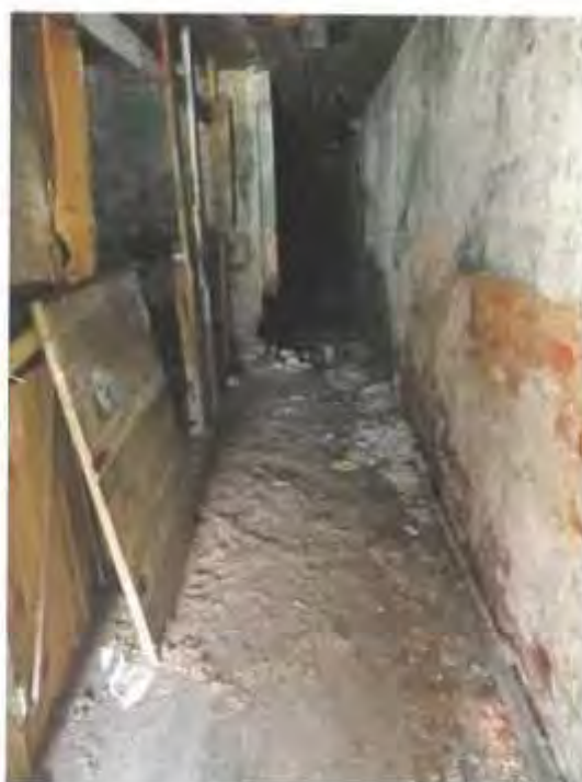
Фото 15. Ч.п.6 (конюшня) пом.1-Н
