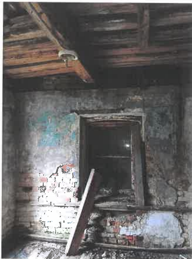
Фото 14. Ч.п.6 (конюшня) пом.1-Н
