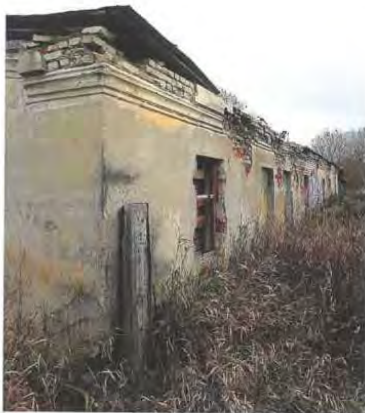
Фото 9. Угол западного и южного фасадов
