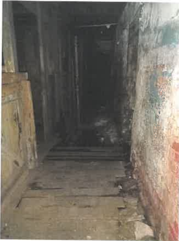
Фото 17. Ч.п.7 (конюшня) пом.1-Н
