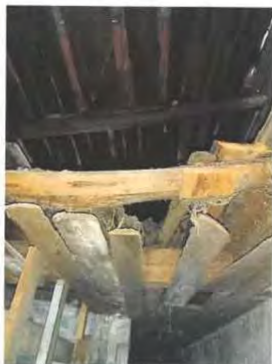
Фото 16. Ч.п.6 (конюшня) пом.1-Н
