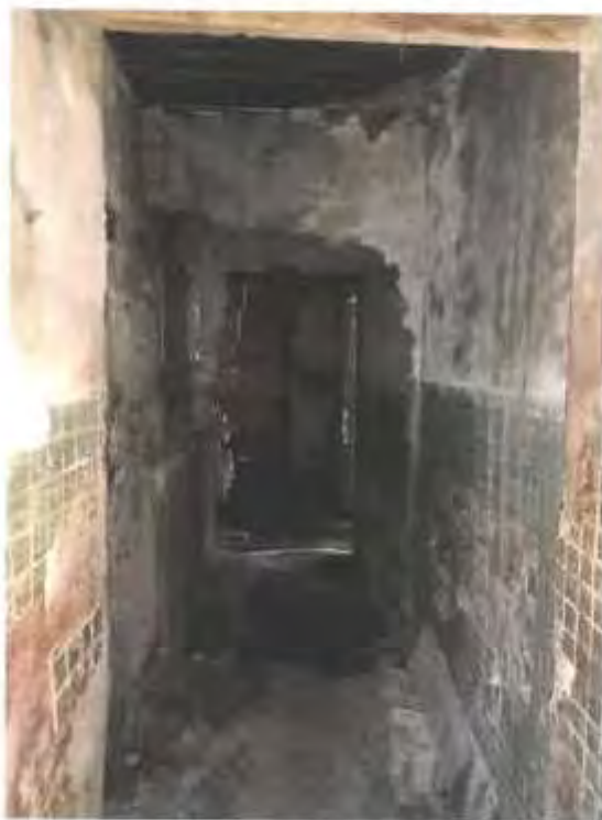
Фото 19. Ч.п.4 пом.1-Н (коридор)
