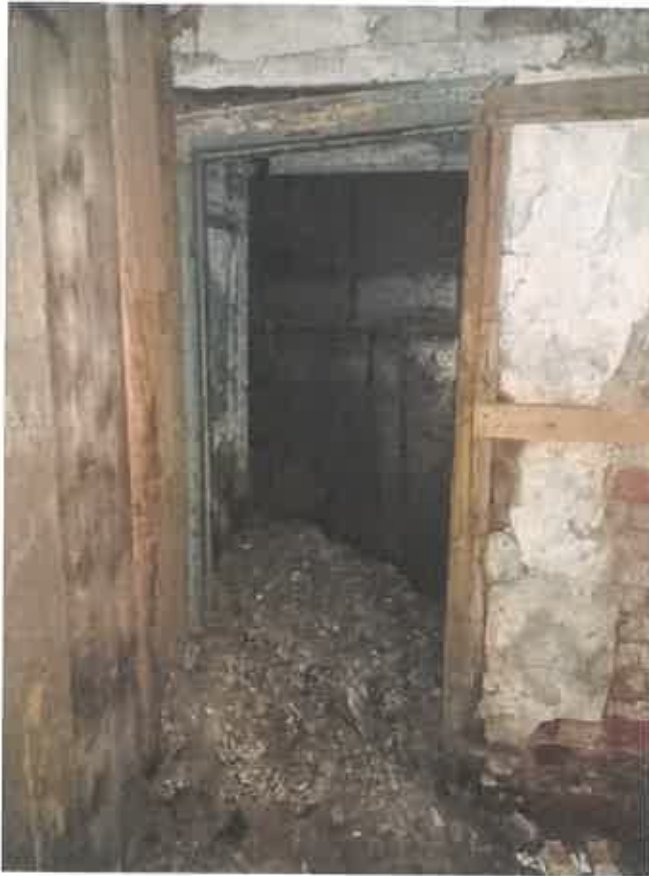
Фото 21. Ч.п.9 (конюшня) пом.1-Н (выход ч/з восточный фасад)
