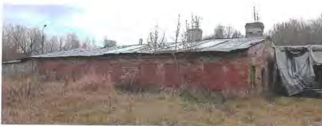
Фото 4. Фасады: северный и часть западного
