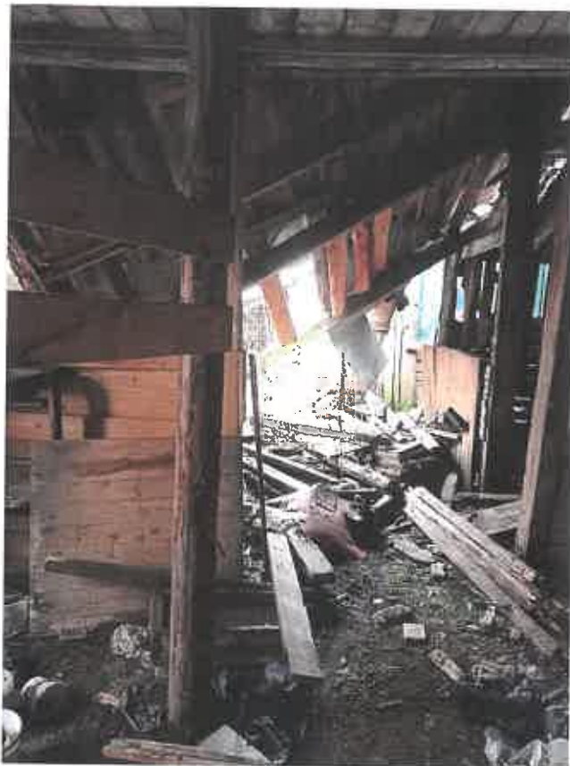
Фото 25. Ч.п.3 (конюшня) пом.1-Н
