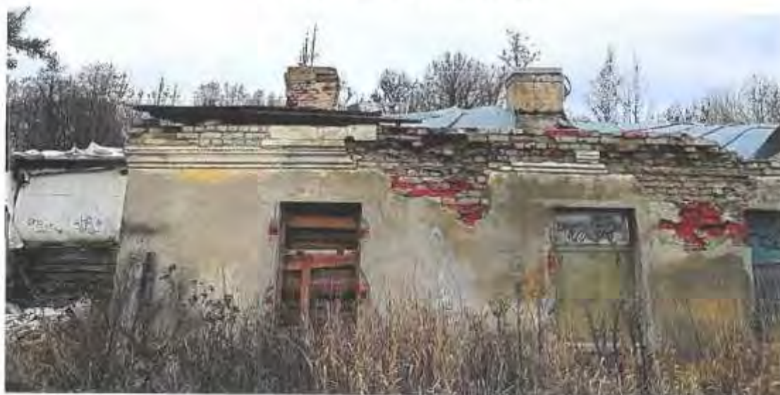
Фото 10. Левая часть южного фасада
