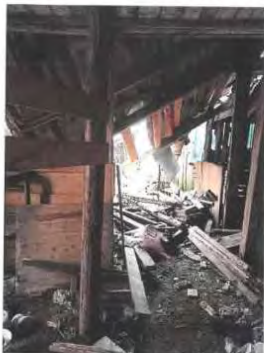
Фото 25. Ч.п.3 (конюшня) пом.1-Н
