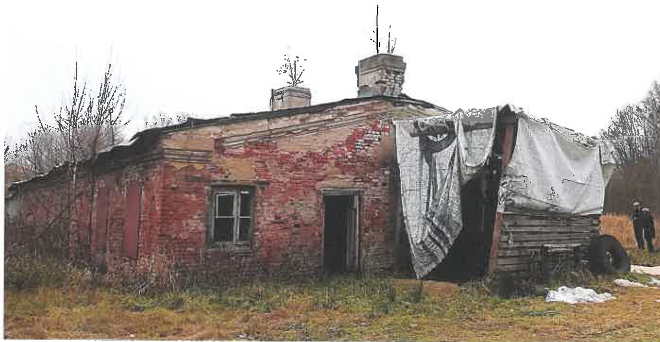
Фото 5. Угол северного и западного фасадов
