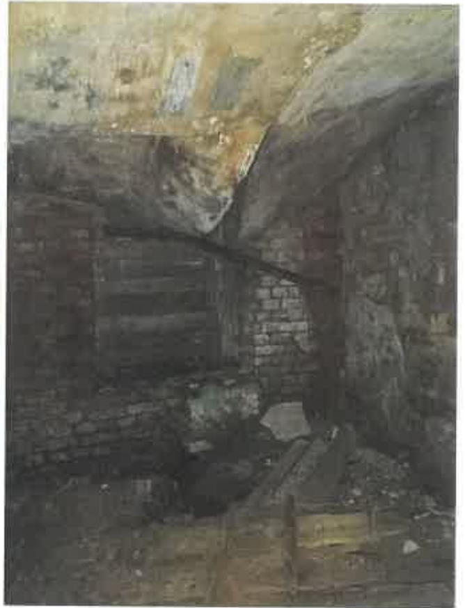
Фото 22. Ч.п.9 (конюшня) пом.1-Н
