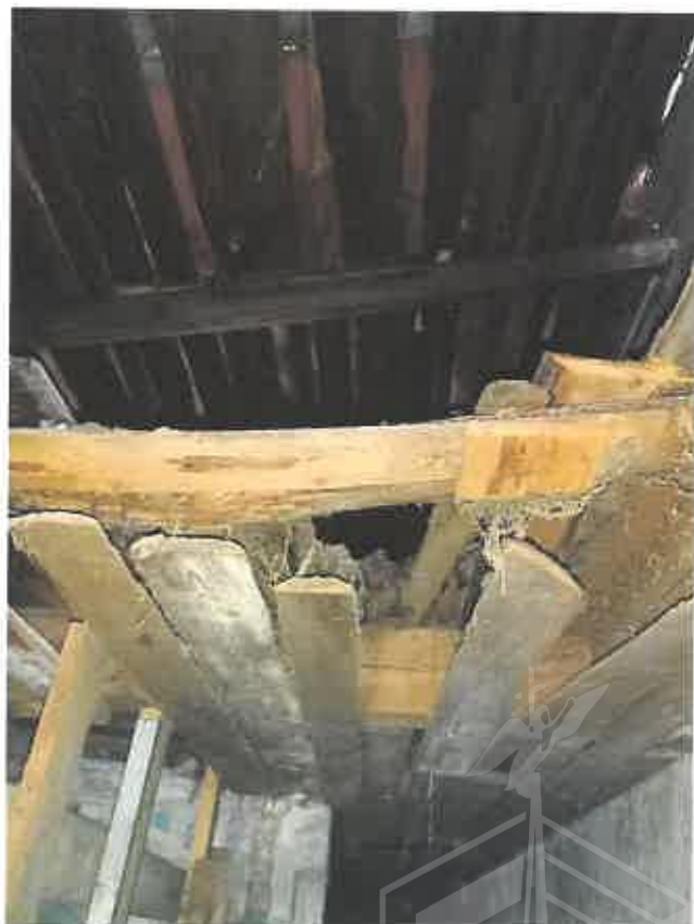
Фото 16. Ч.п.6 (конюшня) пом.1-Н
