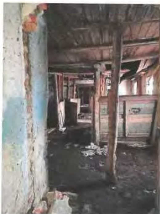
Фото 27. Ч.п.2 (конюшня) пом.1-Н
