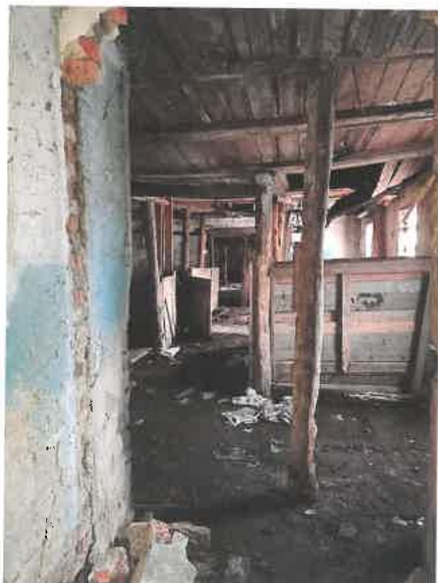
Фото 27. Ч.п.2 (конюшня) пом.1-Н
