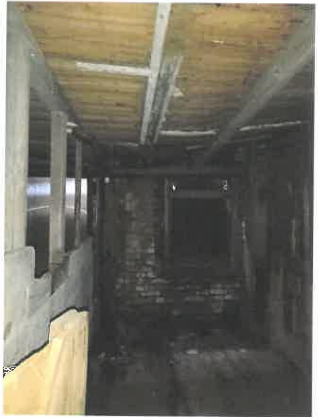
Фото 18. Ч.п.8 (конюшня) пом.1-Н
