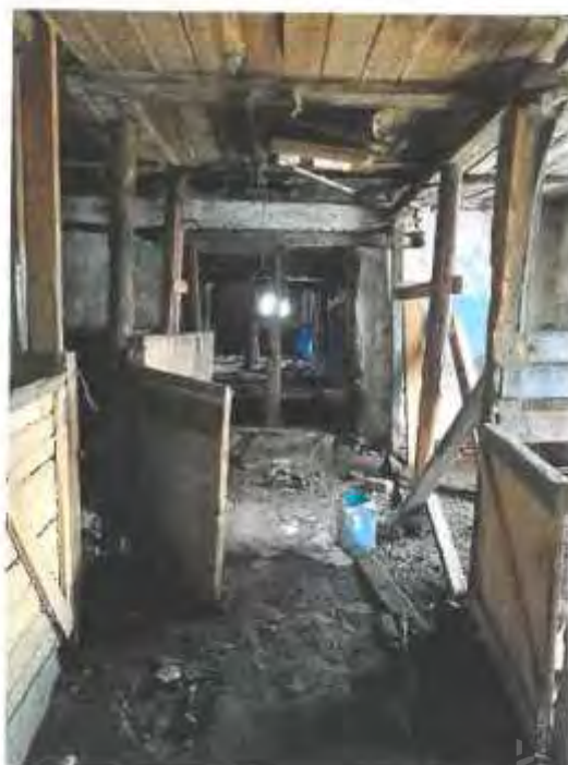
Фото 28. Ч.п.2 (конюшня) пом.1-Н
