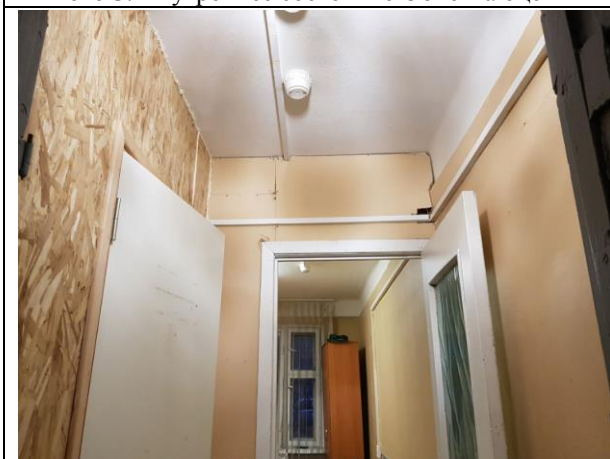
Фото 11. Внутреннее состояние Объекта оценки
