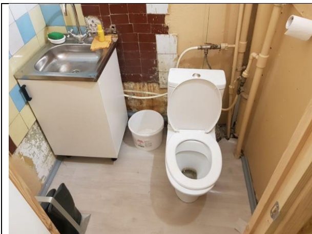
Фото 13. Внутреннее состояние Объекта оценки
