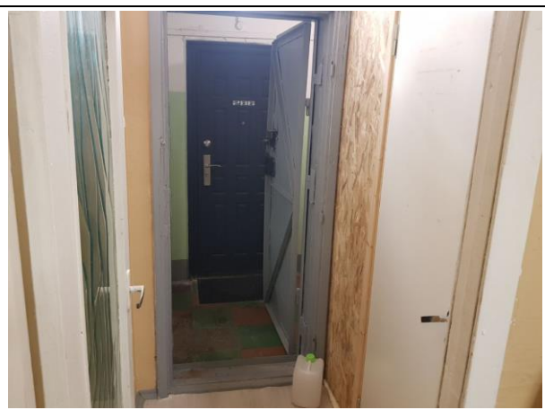
Фото 14. Внутреннее состояние Объекта оценки
