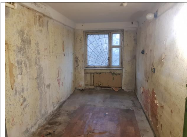
Фото 9. Внутреннее состояние Объекта оценки
