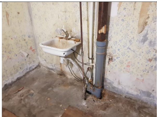
Фото 10. Внутреннее состояние Объекта оценки
