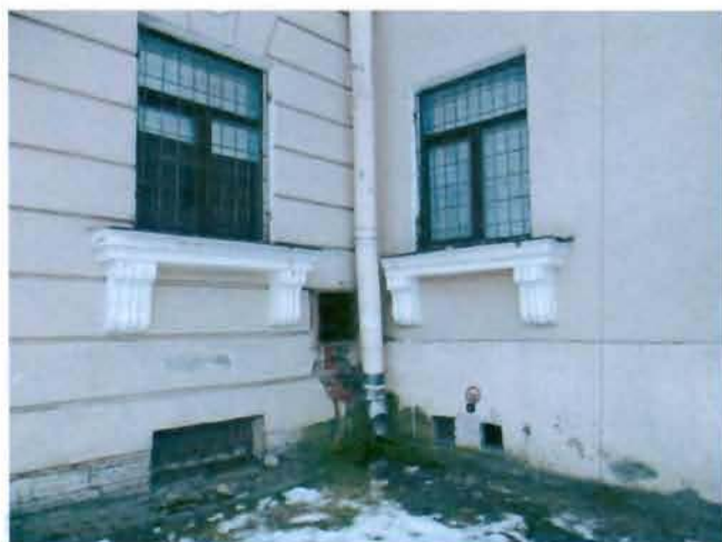
11. Оконные проемы первого этажа.
