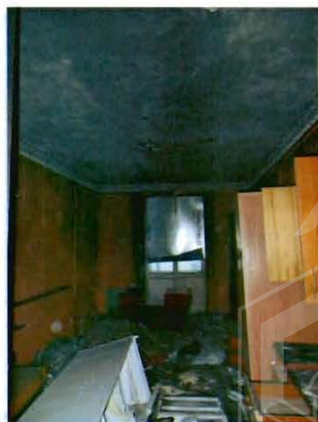
20. Помещение третьего этажа.
