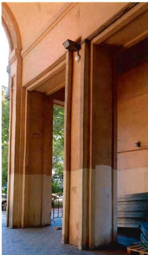
10. Фрагмент. Северная проезжая арка северного флигеля.
