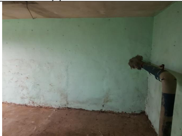
Фото 12. Внутреннее состояние Объекта оценки
