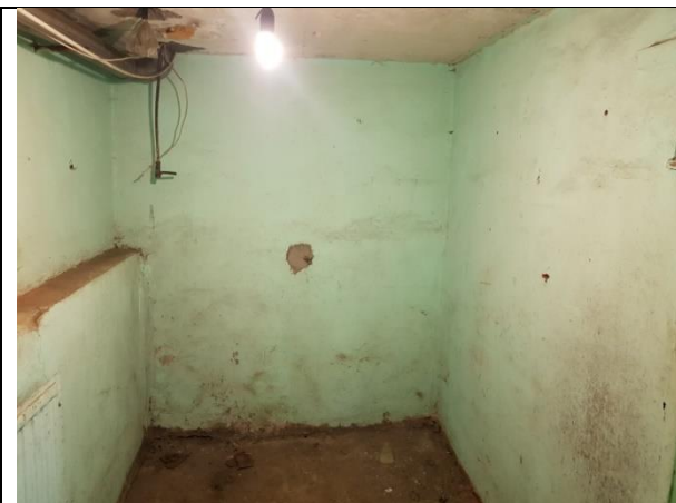
Фото 13. Внутреннее состояние Объекта оценки
