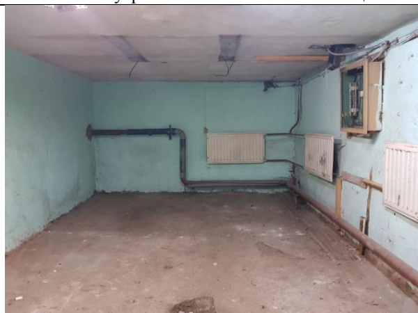
Фото 10. Внутреннее состояние Объекта оценки
