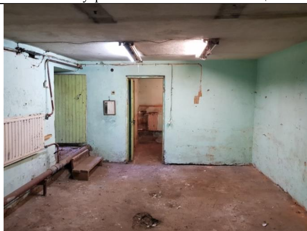
Фото 9. Внутреннее состояние Объекта оценки
