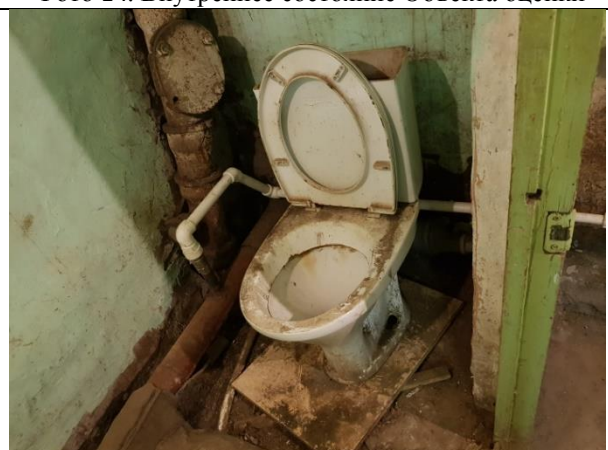
Фото 16. Внутреннее состояние Объекта оценки
