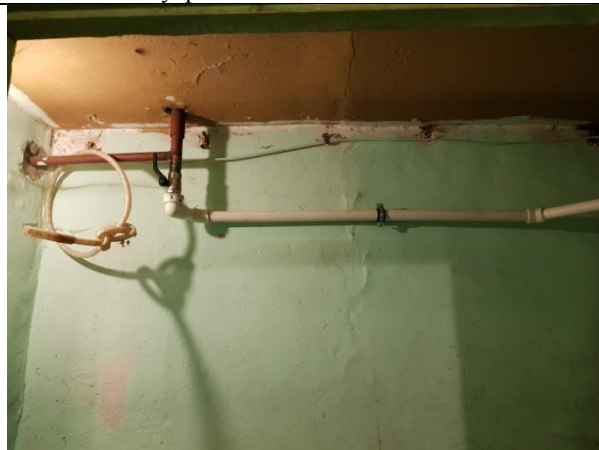
Фото 11. Внутреннее состояние Объекта оценки
