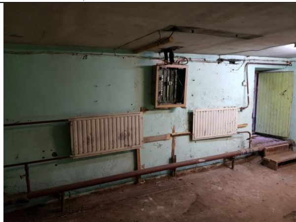
Фото 8. Внутреннее состояние Объекта оценки
