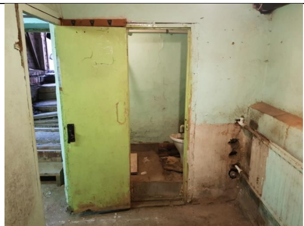
Фото 14. Внутреннее состояние Объекта оценки
