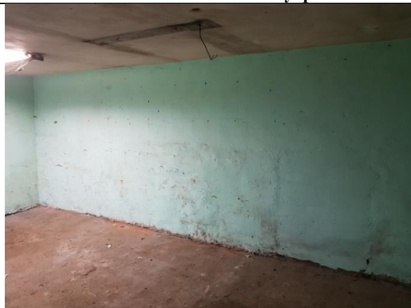
Фото 7. Внутреннее состояние Объекта оценки
