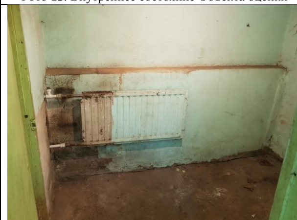
Фото 15. Внутреннее состояние Объекта оценки
