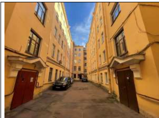
Фото 15. Внутридворовая территория Объекта оценки
