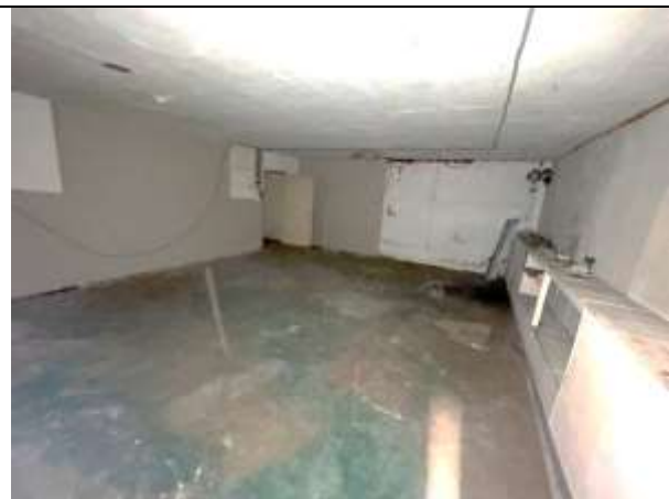
Фото 40. Типичное состояние Объекта оценки
