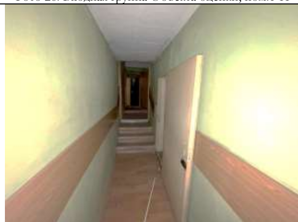
Фото 28. Типичное состояние Объекта оценки
