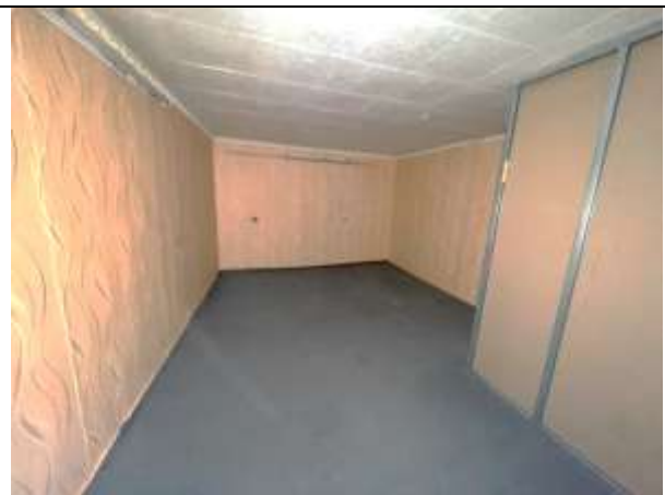
Фото 104. Типичное состояние Объекта оценки
