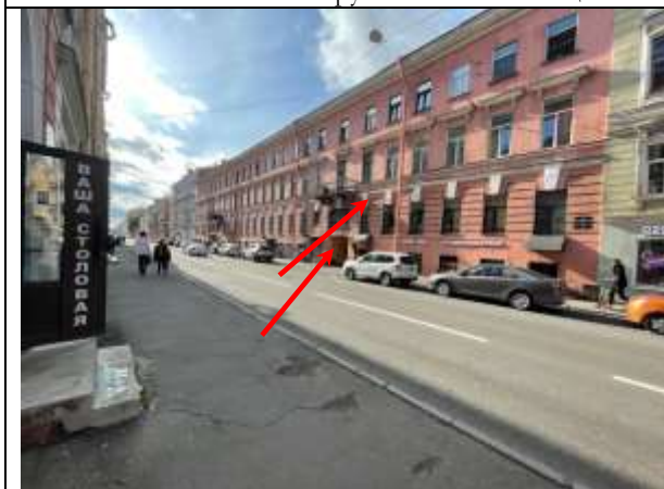
Фото 17. Вид здания расположения Объекта оценки
