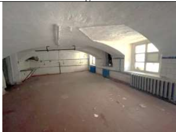
Фото 113. Типичное состояние Объекта оценки
