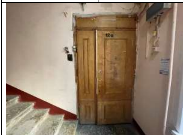
Фото 53. Лестничный проём Объекта оценки
