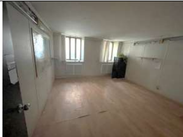
Фото 33. Типичное состояние Объекта оценки
