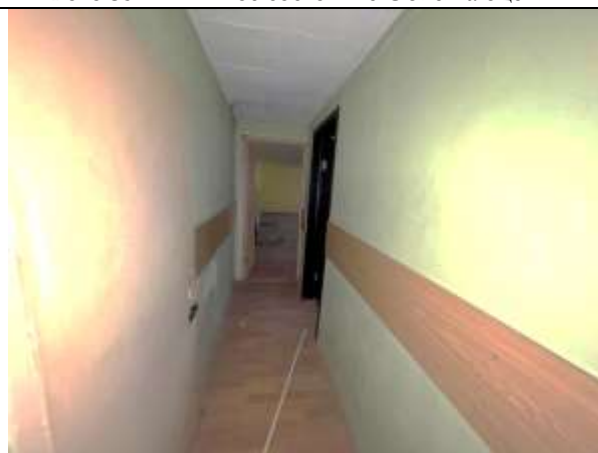
Фото 37. Типичное состояние Объекта оценки
