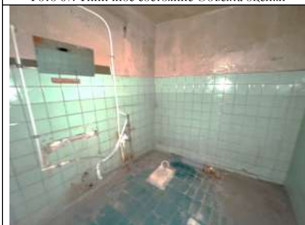
Фото 69. Типичное состояние Объекта оценки
