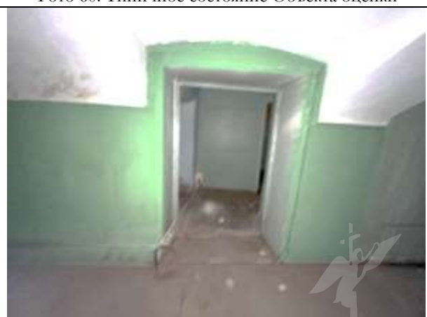
Фото 62. Типичное состояние Объекта оценки
