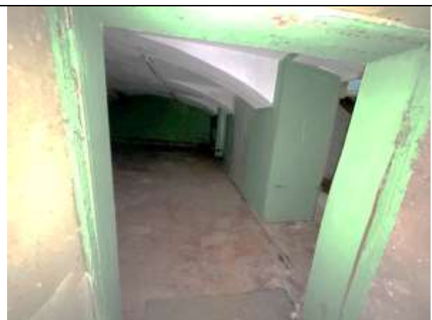
Фото 56. Типичное состояние Объекта оценки
