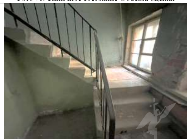
Фото 78. Лестничный проём Объекта оценки, проход на 2-й этаж, пом.2-Н
