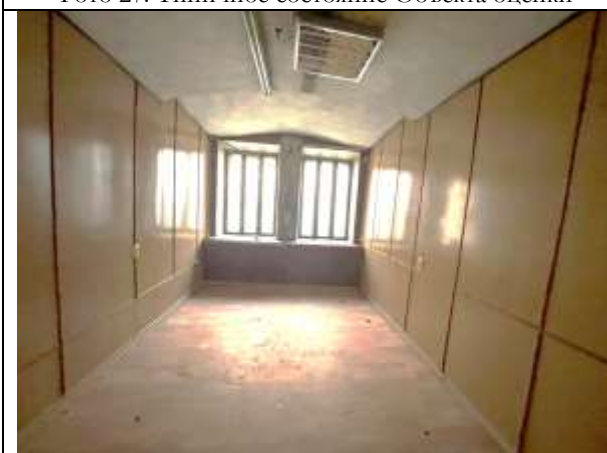
Фото 29. Типичное состояние Объекта оценки
