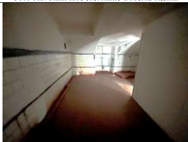
Фото 115. Типичное состояние Объекта оценки
