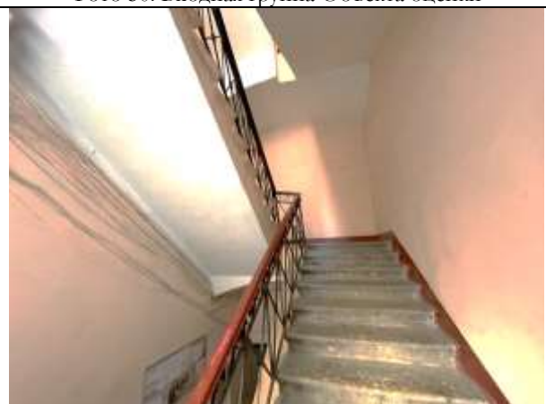
Фото 52. Лестничный проём Объекта оценки
