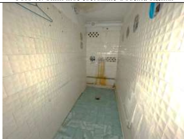
Фото 43. Типичное состояние Объекта оценки
