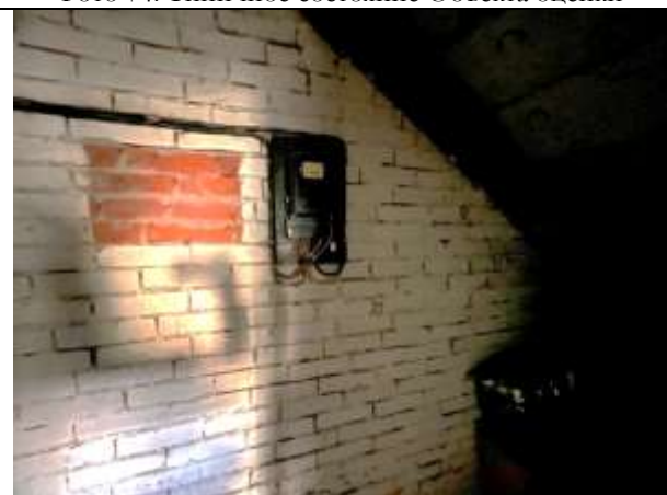
Фото 76. Типичное состояние Объекта оценки
