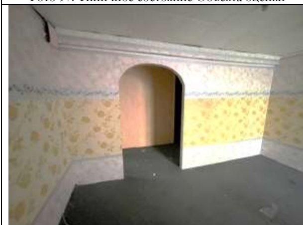
Фото 99. Типичное состояние Объекта оценки
