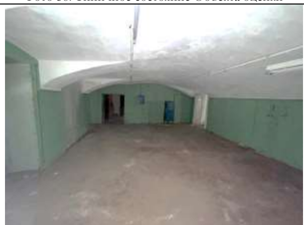
Фото 60. Типичное состояние Объекта оценки
