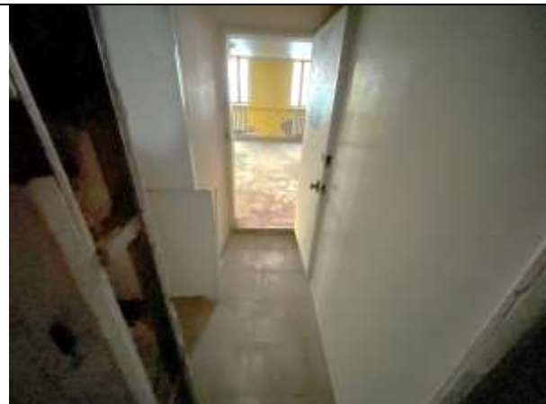
Фото 42. Типичное состояние Объекта оценки
