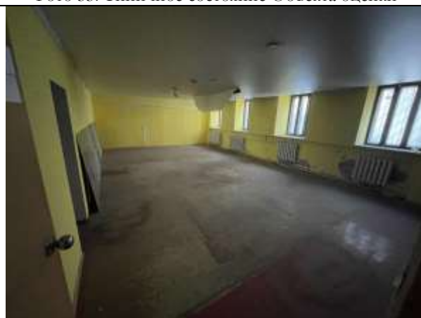
Фото 35. Типичное состояние Объекта оценки
