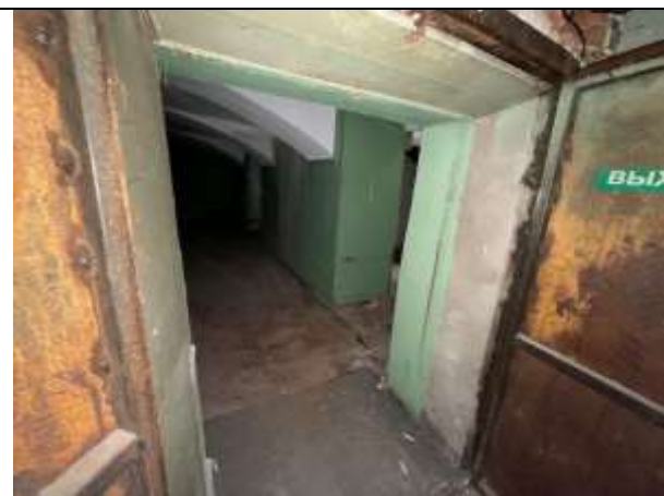
Фото 72. Типичное состояние Объекта оценки
