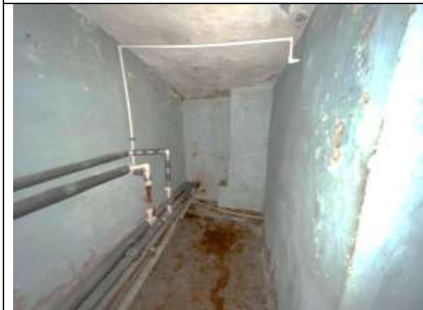
Фото 65. Типичное состояние Объекта оценки
