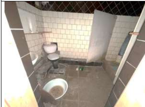
Фото 49. Типичное состояние Объекта оценки
