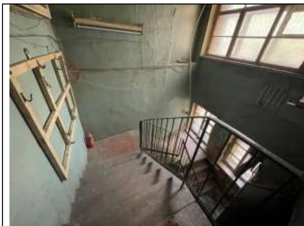
Фото 79. Лестничный проём Объекта оценки, проход на 2-й этаж, пом.2-Н
