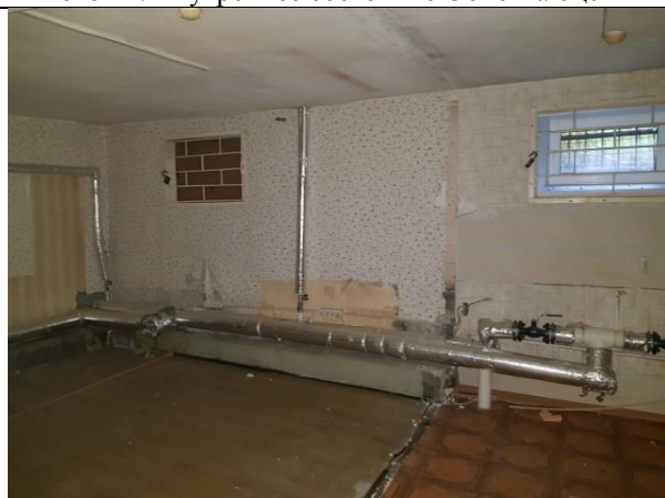
Фото 16. Внутреннее состояние Объекта оценки
