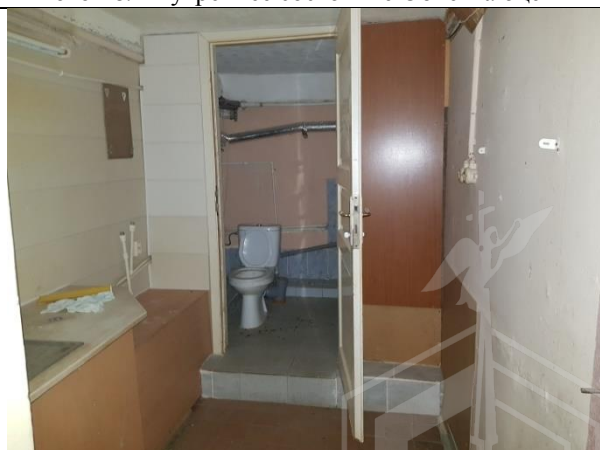
Фото 18. Внутреннее состояние Объекта оценки
