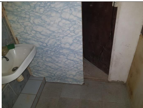
Фото 12. Внутреннее состояние Объекта оценки
