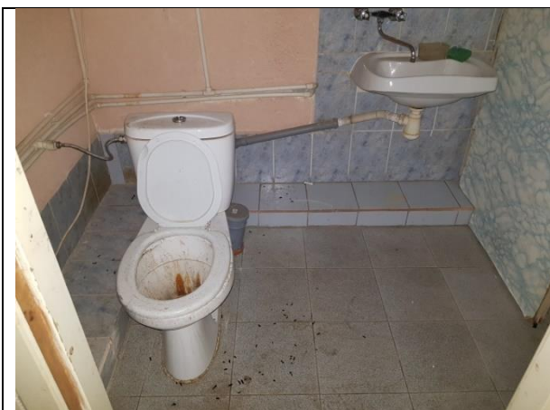
Фото 19. Внутреннее состояние Объекта оценки
