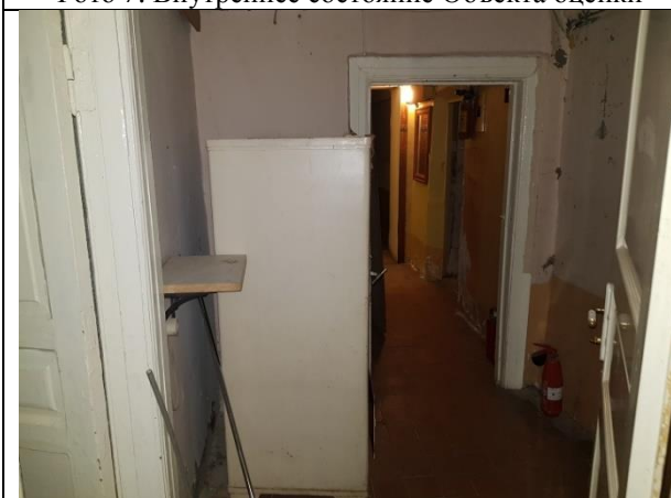
Фото 9. Внутреннее состояние Объекта оценки
