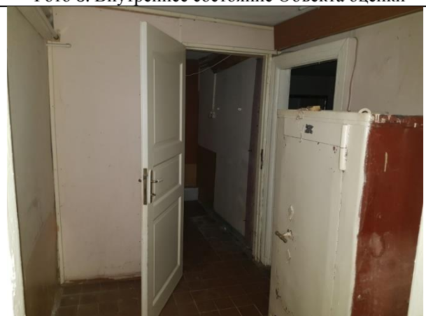
Фото 10. Внутреннее состояние Объекта оценки
