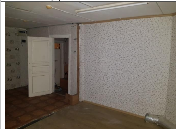
Фото 13. Внутреннее состояние Объекта оценки
