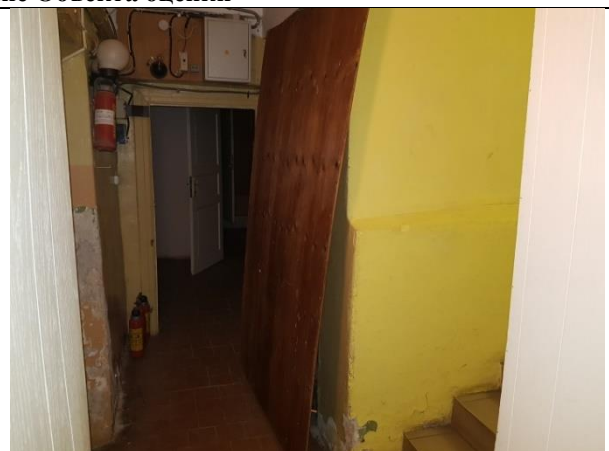
Фото 8. Внутреннее состояние Объекта оценки
