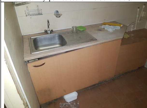
Фото 17. Внутреннее состояние Объекта оценки
