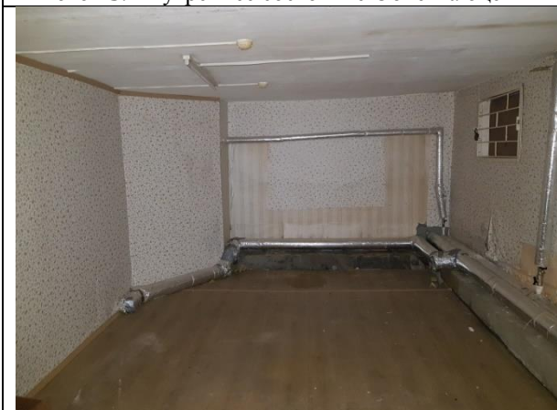
Фото 15. Внутреннее состояние Объекта оценки
