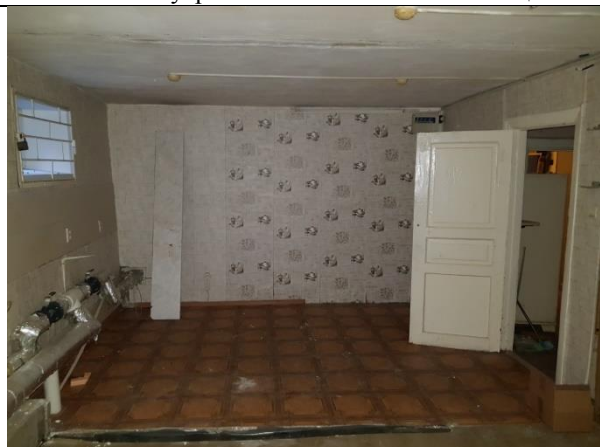
Фото 14. Внутреннее состояние Объекта оценки
