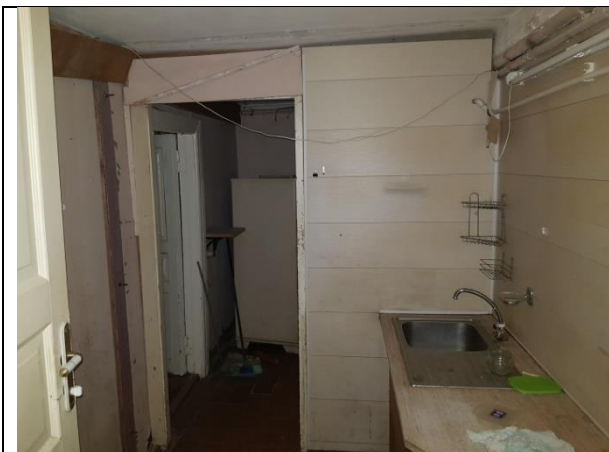
Фото 11. Внутреннее состояние Объекта оценки
