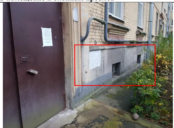
Фото 6. Вид окон Объекта оценки
