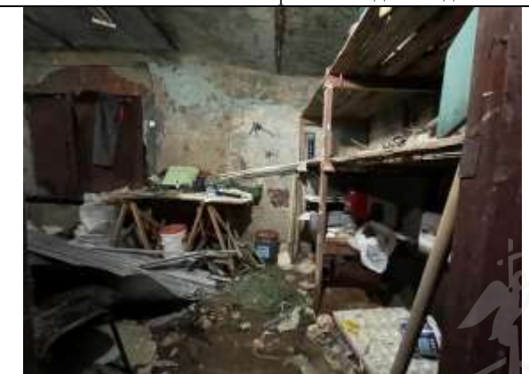
Фото 22. Типичное состояние Объекта оценки
