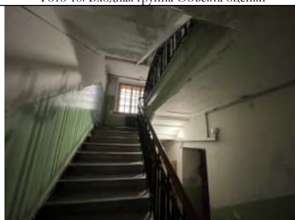
Фото 20. Лестничный проём соседнего здания
