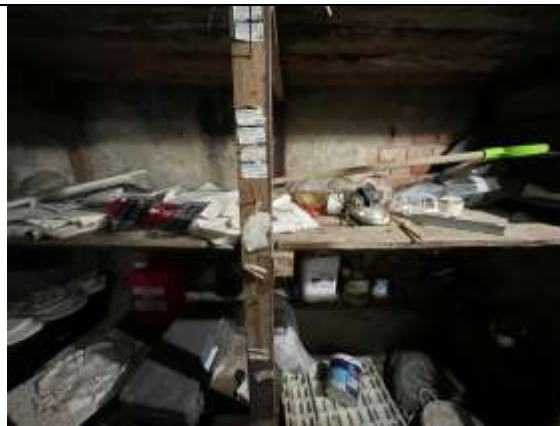
Фото 24. Типичное состояние Объекта оценки
