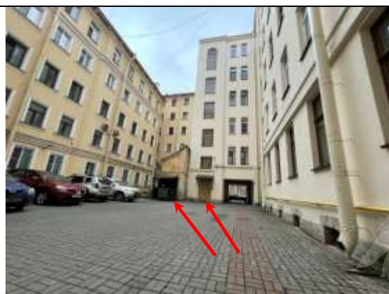
Фото 14. Внутридворовая территория здания расположения Объекта оценки
