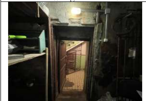
Фото 21. Типичное состояние Объекта оценки
