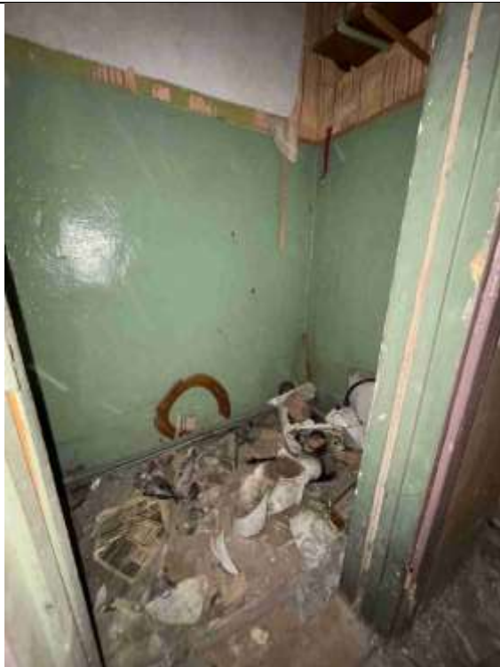
Фото 29. Типичное состояние Объекта оценки
