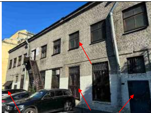
Фото 14. Вид Объекта оценки, входная и оконная группа Объекта оценки
