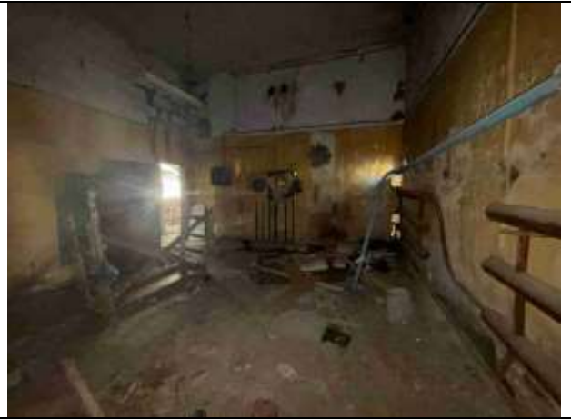
Фото 32. Типичное состояние Объекта оценки
