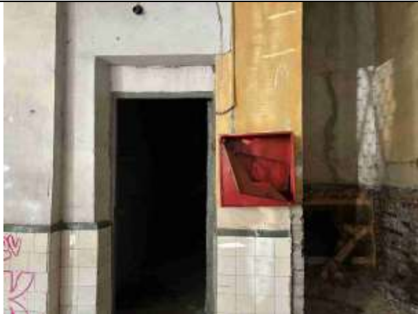
Фото 27. Типичное состояние Объекта оценки
