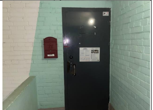
Фото № 24 – Вход в помещение
