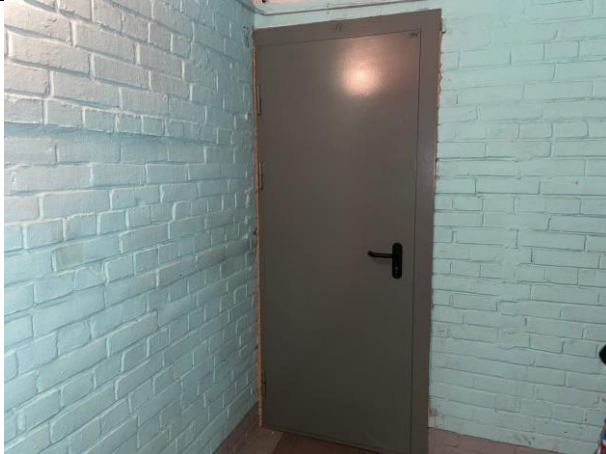
Фото № 31 – Вход в помещение
