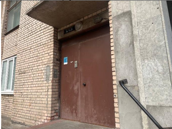
Фото № 23 – Общий вход
