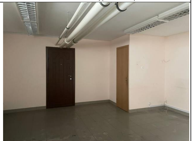
Фото № 26 – Внутреннее состояние помещения
