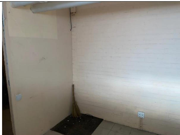
Фото № 38 – Внутреннее состояние помещения
