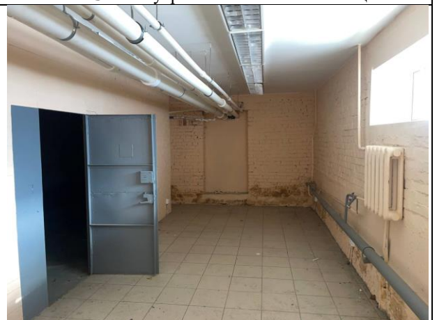
Фото № 34 – Внутреннее состояние помещения
