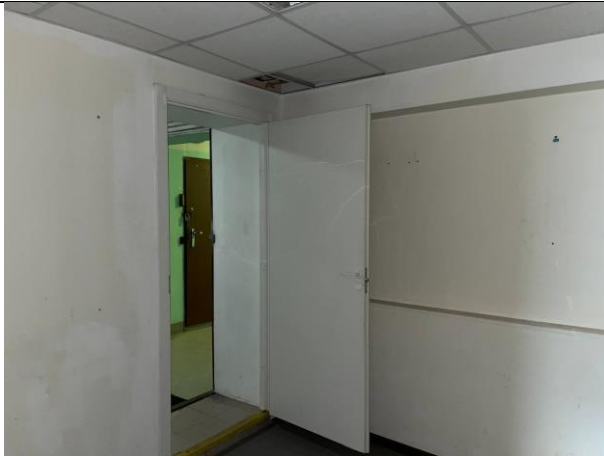
Фото № 21 – Внутреннее состояние помещения
