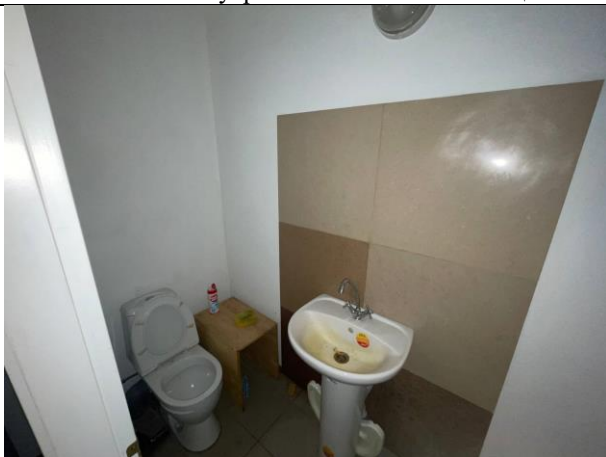
Фото № 15 – Внутреннее состояние помещения
