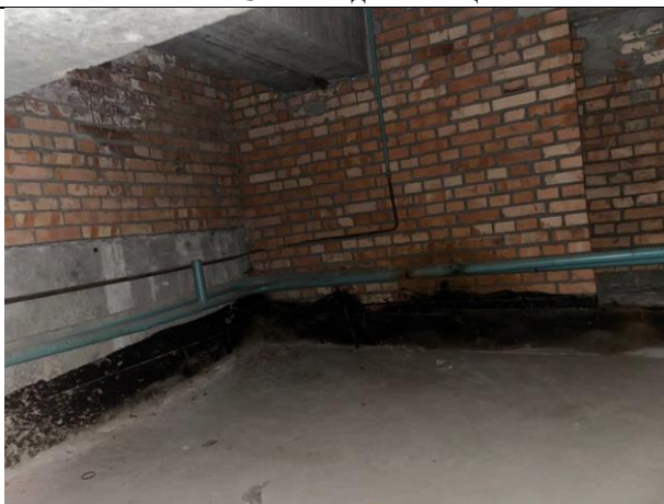
Фото № 33 – Внутреннее состояние помещения
