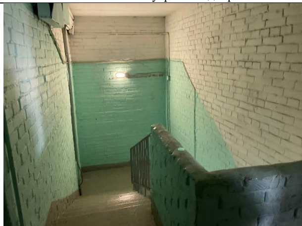
Фото № 10 – Лестничная клетка
