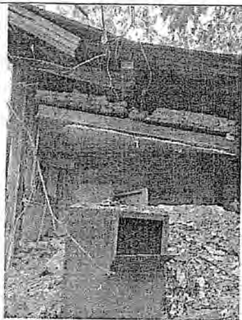
13. Обрушение конструкций стены и перекрытия центрального ризалита
