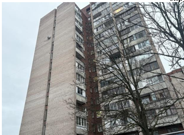
Фото 1. Вид здания Объекта оценки
