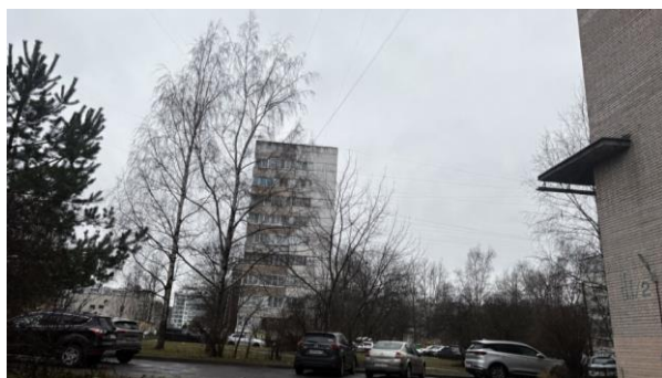
Фото 3. Вид здания Объекта оценки. Дворовая территория
