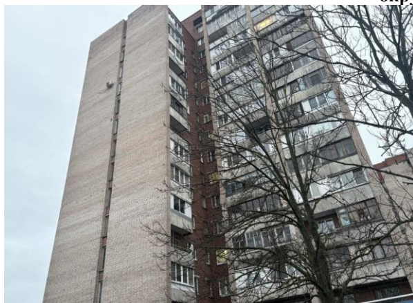
Фото 1. Вид здания Объекта оценки
