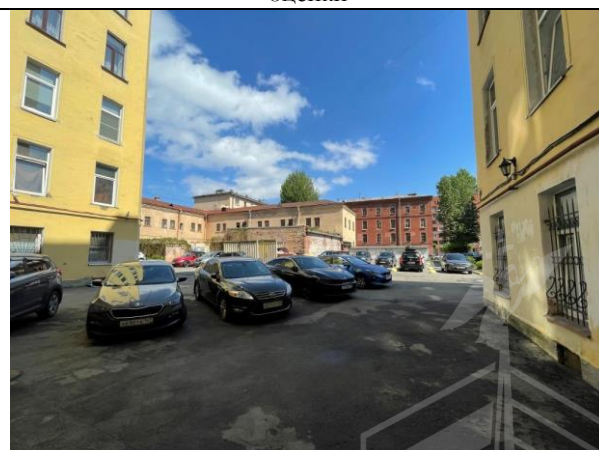
Фото 12. Внутридворовая территория Объекта оценки
