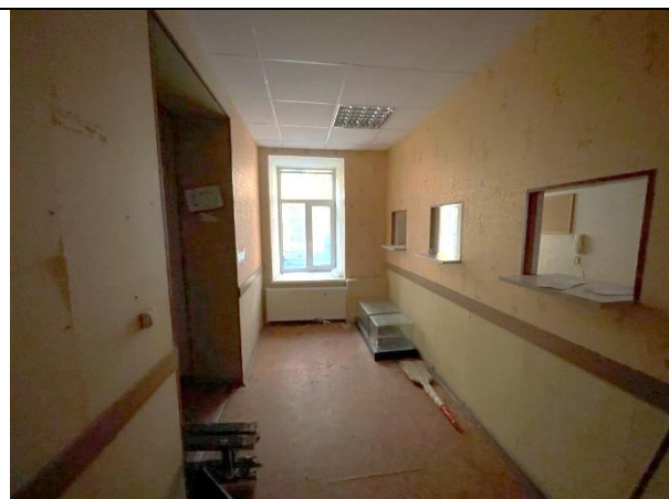
Фото 22. Типичное состояние Объекта оценки
