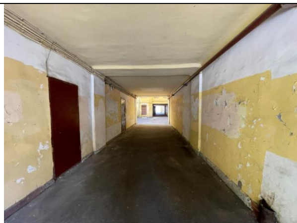
Фото 9. Проход через арку
