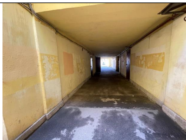
Фото 11. Проход через арку
