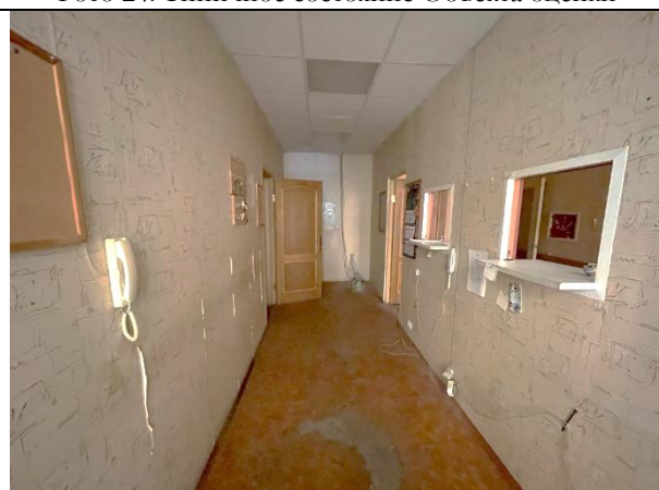
Фото 26. Типичное состояние Объекта оценки
