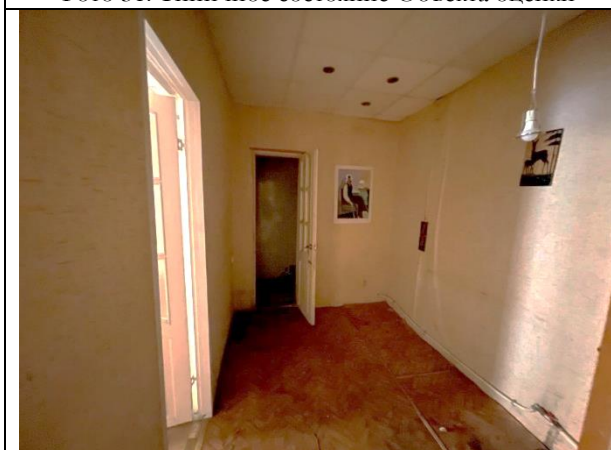
Фото 33. Типичное состояние Объекта оценки
