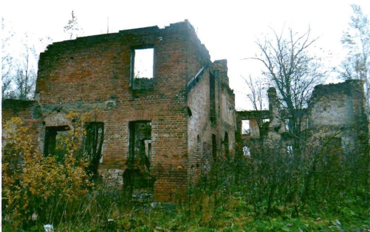
Фото №3. Западный фасад.
