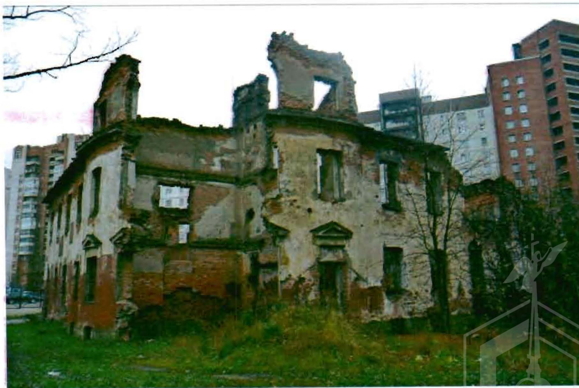
Фото №2. Северный фасад.
