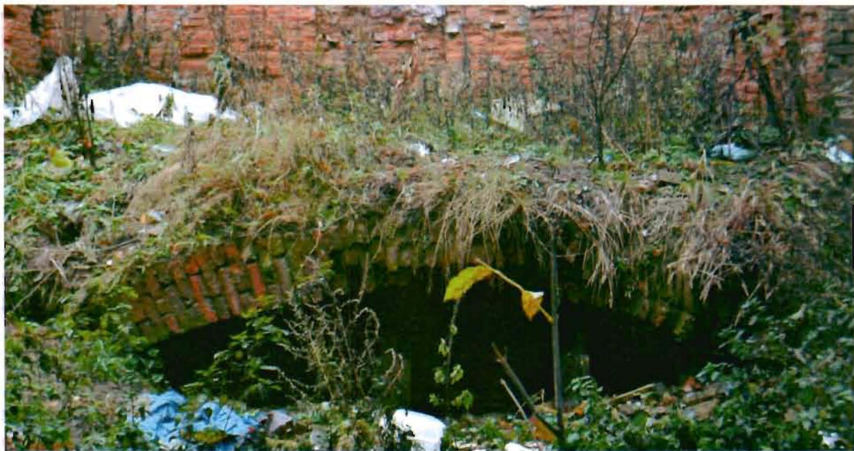
Фото №6. Интерьер. Часть свода подвала.
