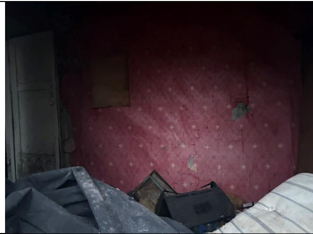
Фото 11. Внутреннее состояние Объекта оценки
