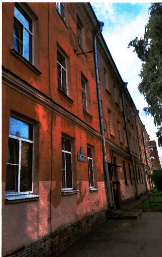
Фото 5 Фрагмент объекта культурного наследия. Западный дворовый фасад. Вид с северо-запада. Фото выполнено 30.07.2024.
