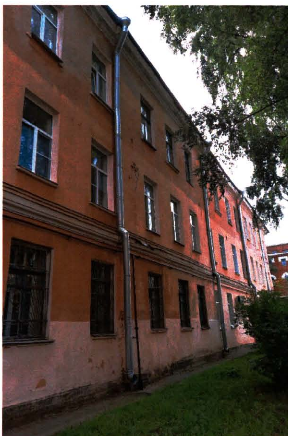
Фото 6 Фрагмент объекта культурного наследия. Западный дворовый фасад. Вид с северо-запада. Фото выполнено 30.07.2024.
