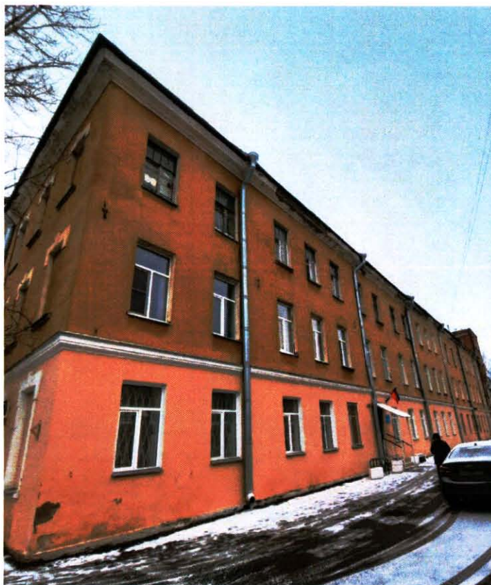
Фото 3 Общий вид. Восточный лицевой фасад. Фото выполнено 12.02.2025.
