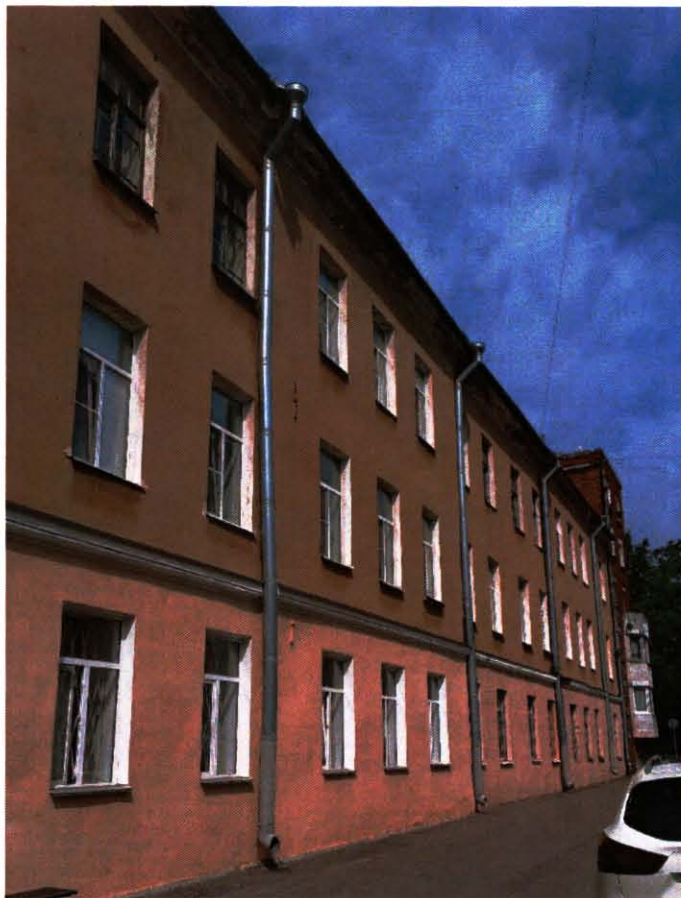
Фото 9 Фрагмент объекта культурного наследия. Восточный лицевой фасад. Вид с юго-востока. Фото выполнено 19.08.2024.
