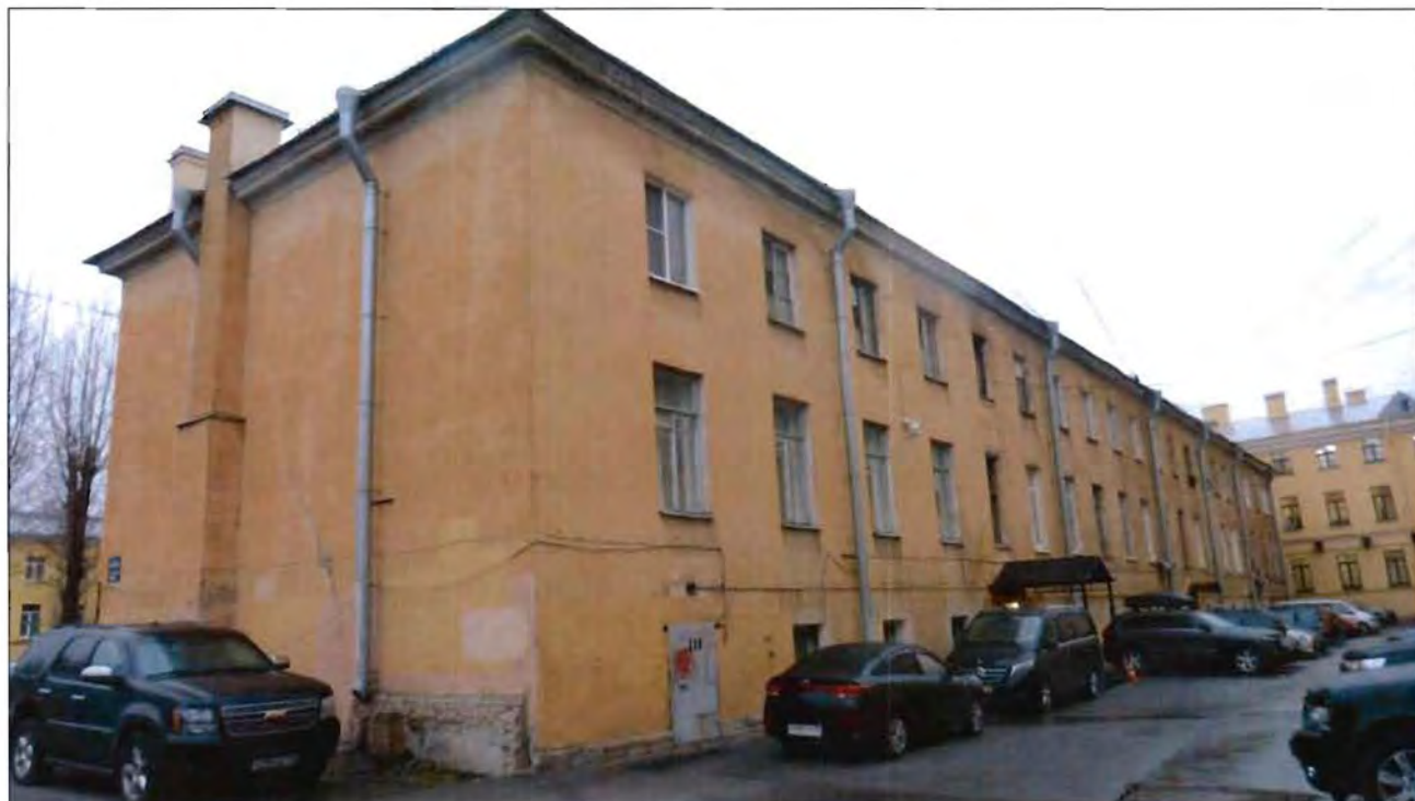
10. Корпус 2, литера Б. Вид с востока.
