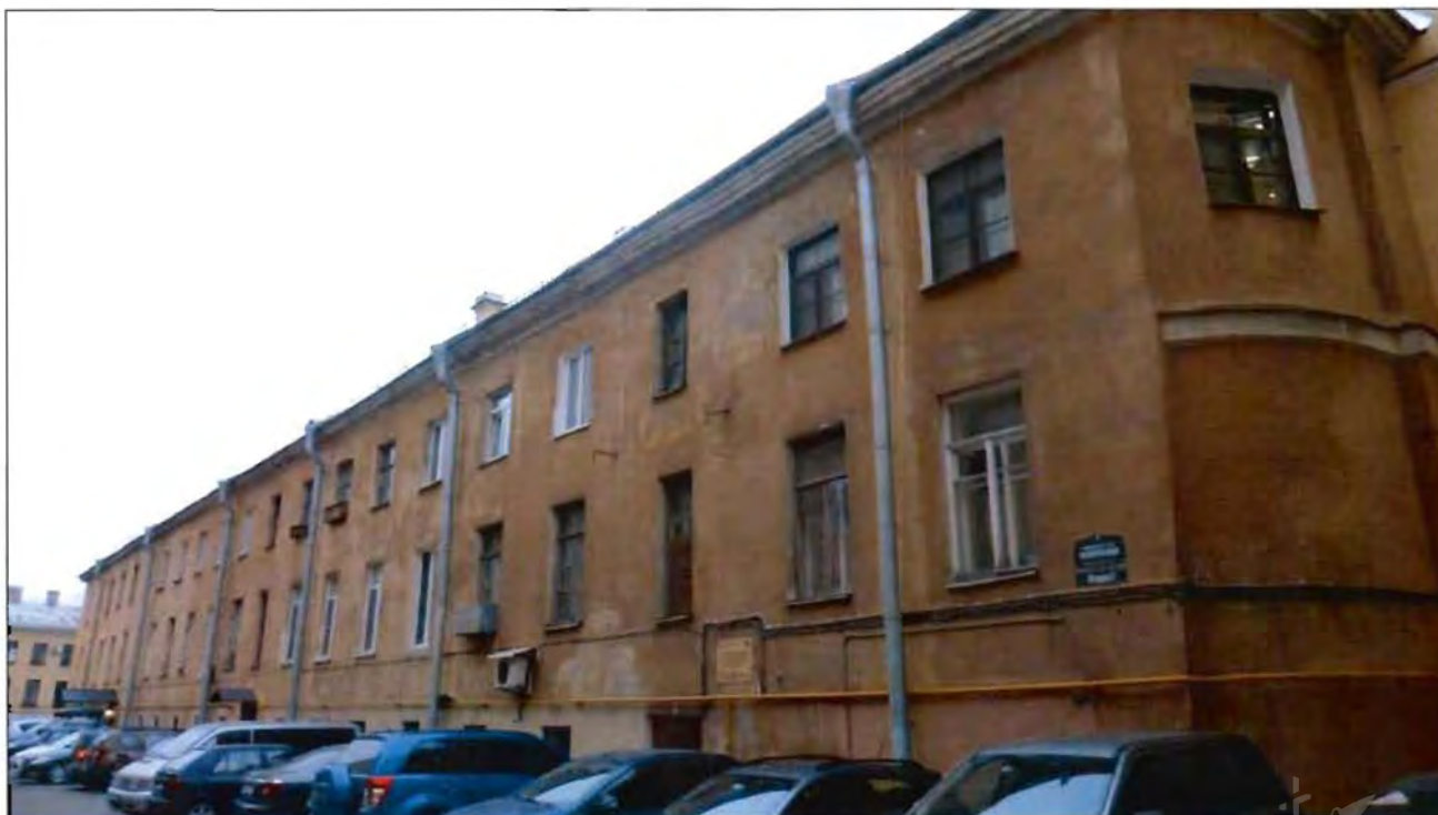
11. Корпус 2, литера Б. Вид с севера.
